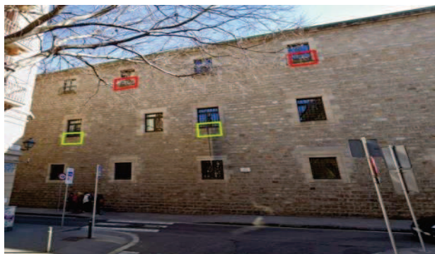
Façana Carrer del Carme
