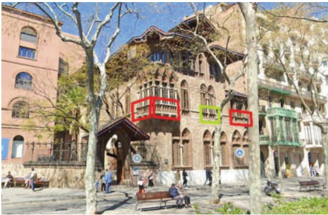
Façana Gran Via de les Corts Catalanes, 491
