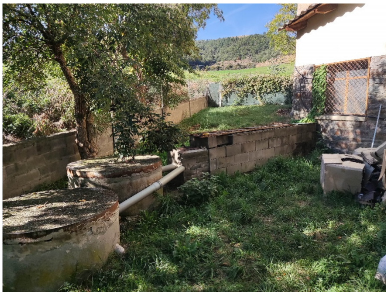
Fotografia 1. Imatge dels dos pous secs i de la claveguera que els connecta amb la edificació.
