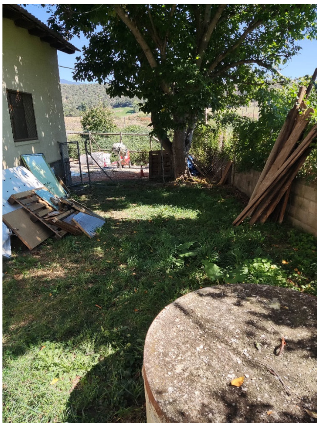
Fotografia 2. Ubicació on s'ha d'instal·lar la depuradora ecològica, vora el nouer.
