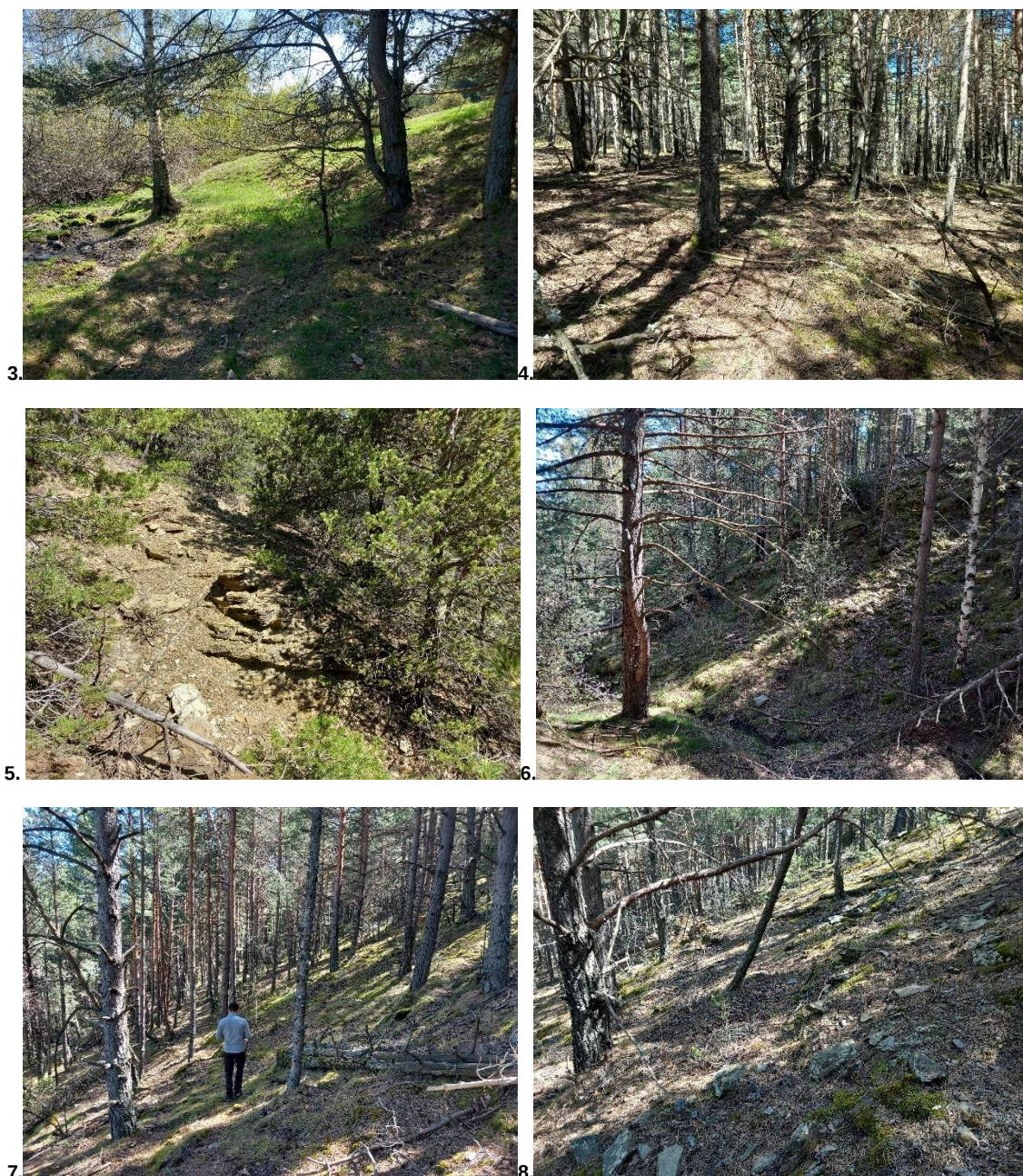
Imatge 14. Foto 1: Zona inicial on hi ha més afloraments de roca. Foto 2: Punt de pas obligat, al final del primer tram de pujada, per passar per sobre uns cingles de roca. Foto 3: Tram on cal instal·lar tub de drenatge i fer aportació de graves de drenatge. Foto 4: Tram de pista forestal en zona boscosa amb poca pendent transversal. Foto 5: Segon tram de solell amb sòl prim i presència d'afloraments rocosos. Foto 6: Punt de creuament del barranc més important a travessar, provinent de Coll de Jou on s'instal·larà el tub 5 (T5). Fotos 7 i 8: Trams en zona boscosa de pendent transversal moderada. (Font: elaboració pròpia)
