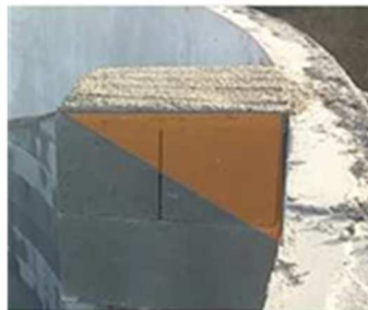
Esquema en taronja de l'acabat en angle de 65° (la foto real acaba en angle recte)
