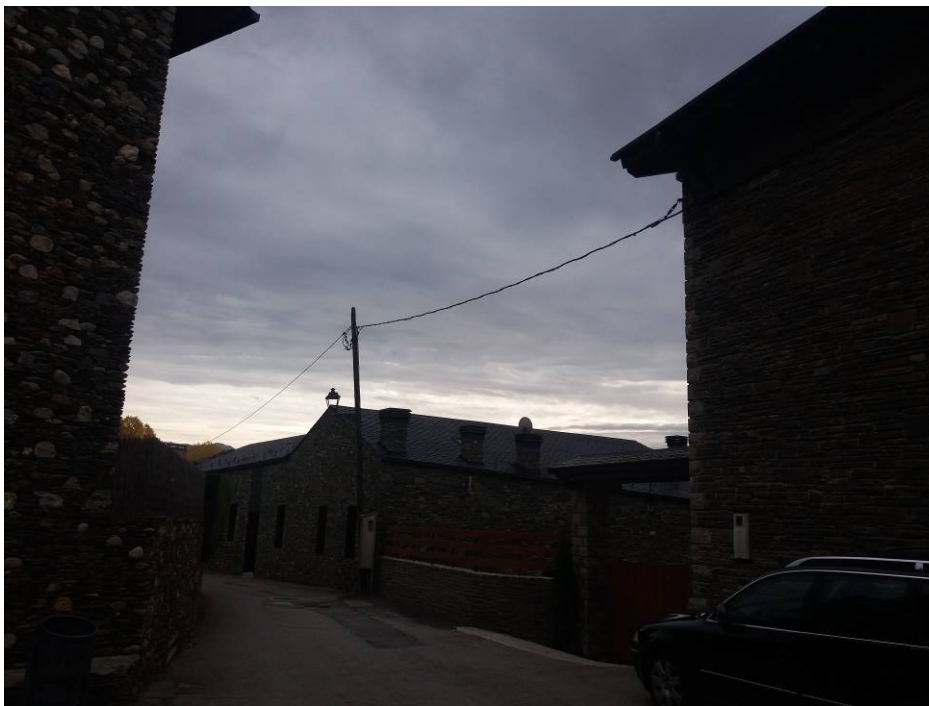
Vista de carrer actual de pas aeri d'enllumenat i baixa tensió, s'aprecia un suport de fusta.
