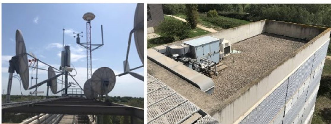
Figura 3. Coberta dels dos edificis, B4 i B6
