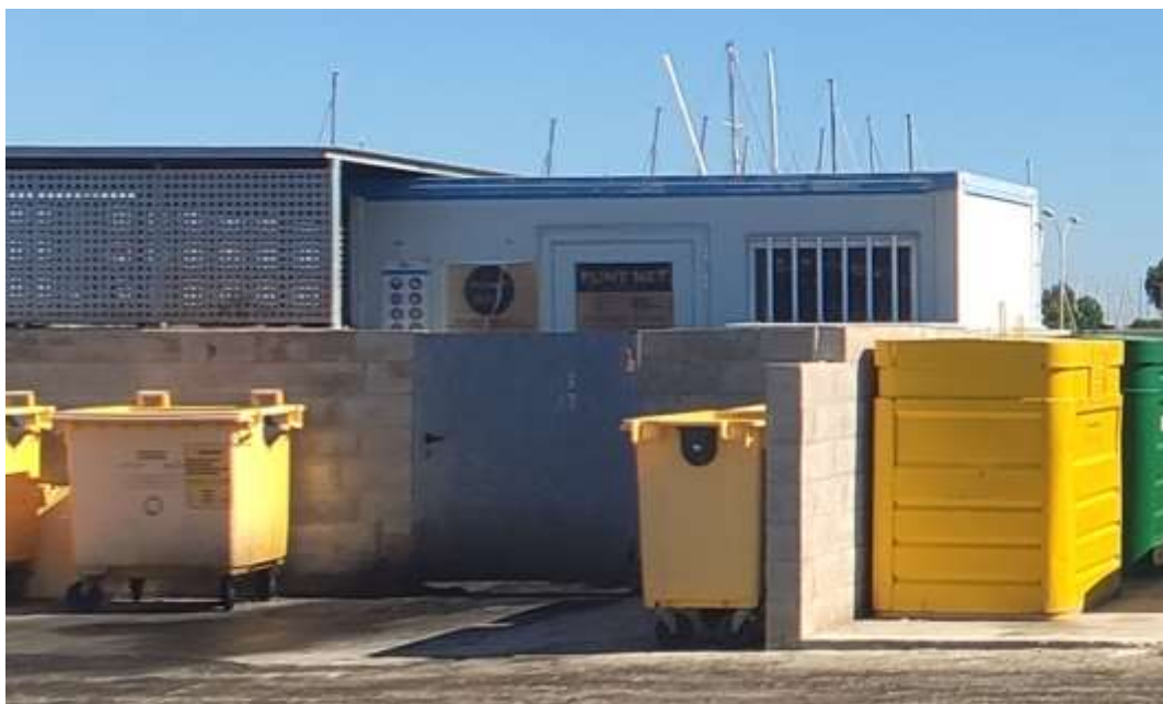
Imatge nº8. Zona accés caseta prefabricada.
