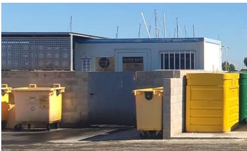
Imatge nº8. Zona accés caseta prefabricada.
