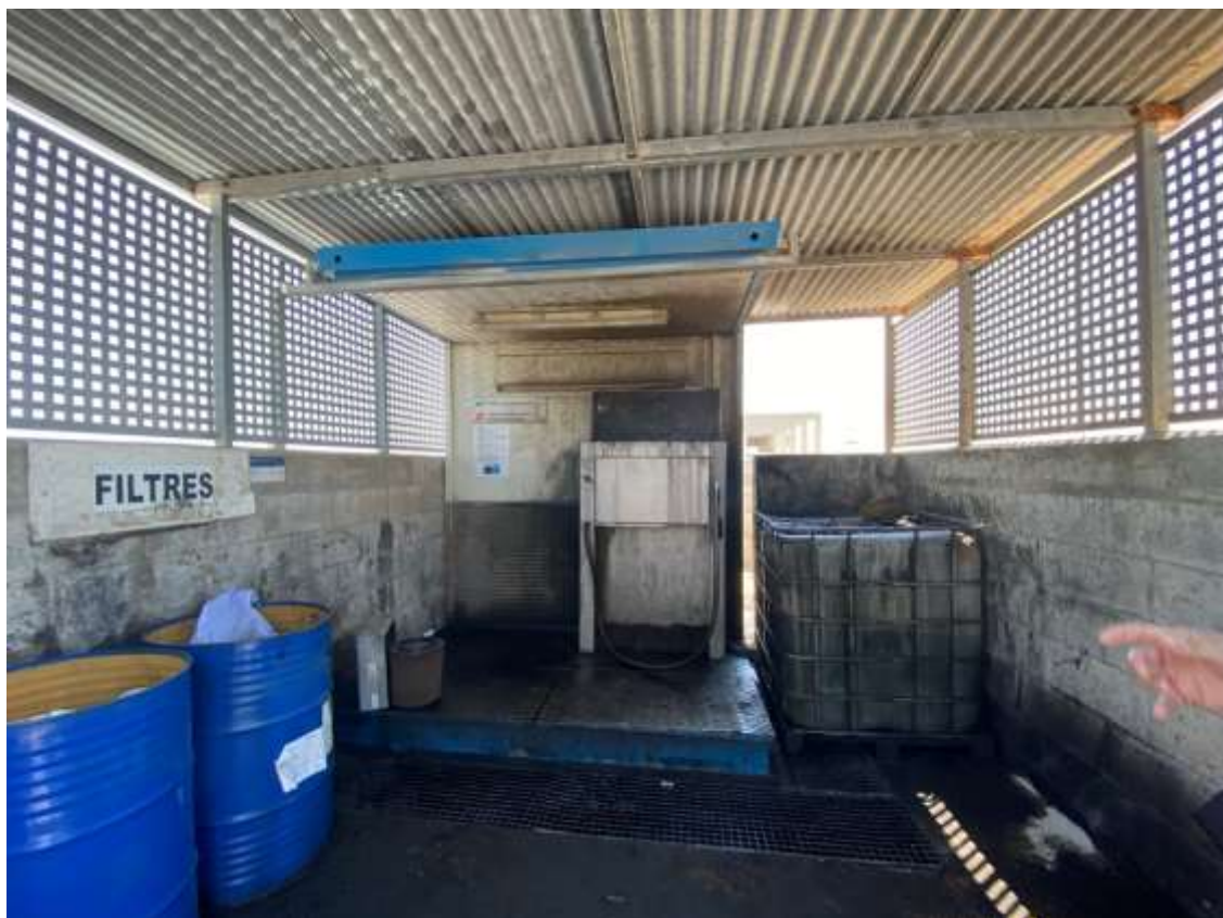
Imatge nº3. Zona recepció olis industrial usats.
