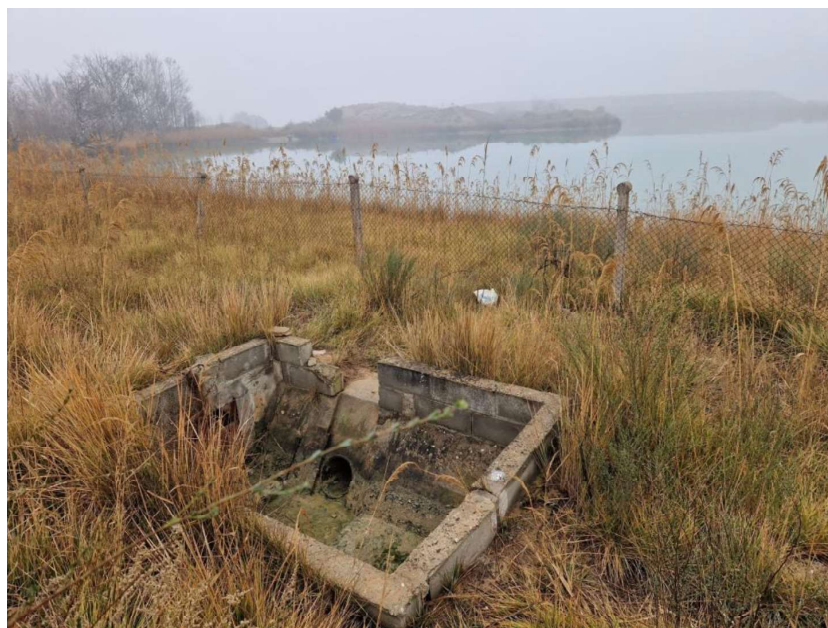
Arqueta d'entrada d'aigua al pantà
