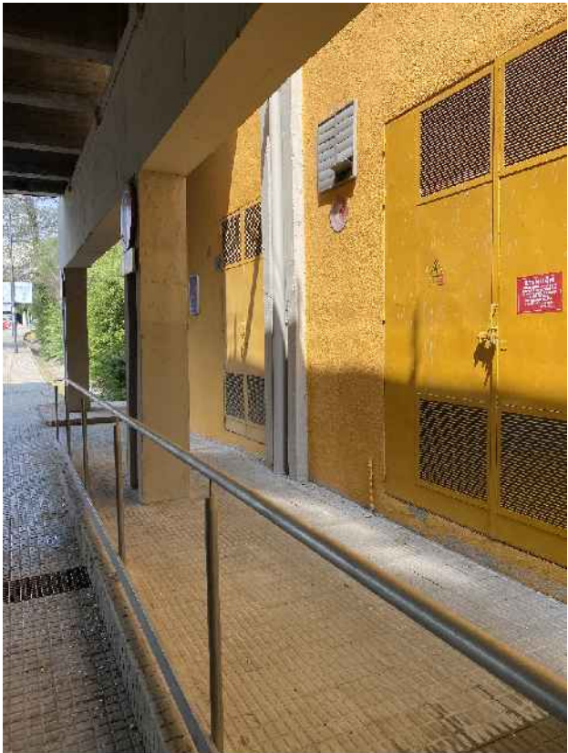
ACCÉS A SALA MANOBRA i SALA TRAFOS
