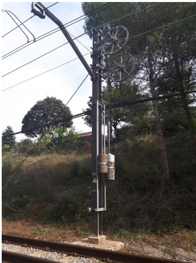
Sistema de compensació doble ECP-2 a la sortida de l'estació de La Pobla de Claramunt
