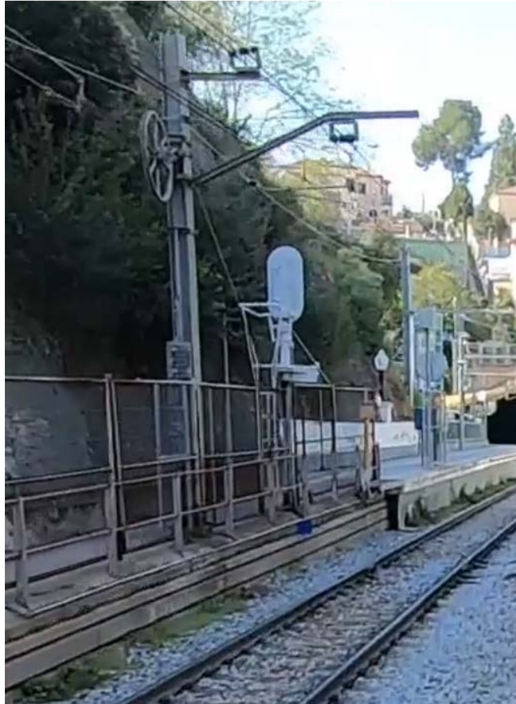
Compensació mecànica existent estació de La Floresta
