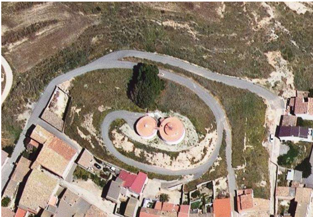
Figura 4: Dipòsit de distribució de Sunyer
