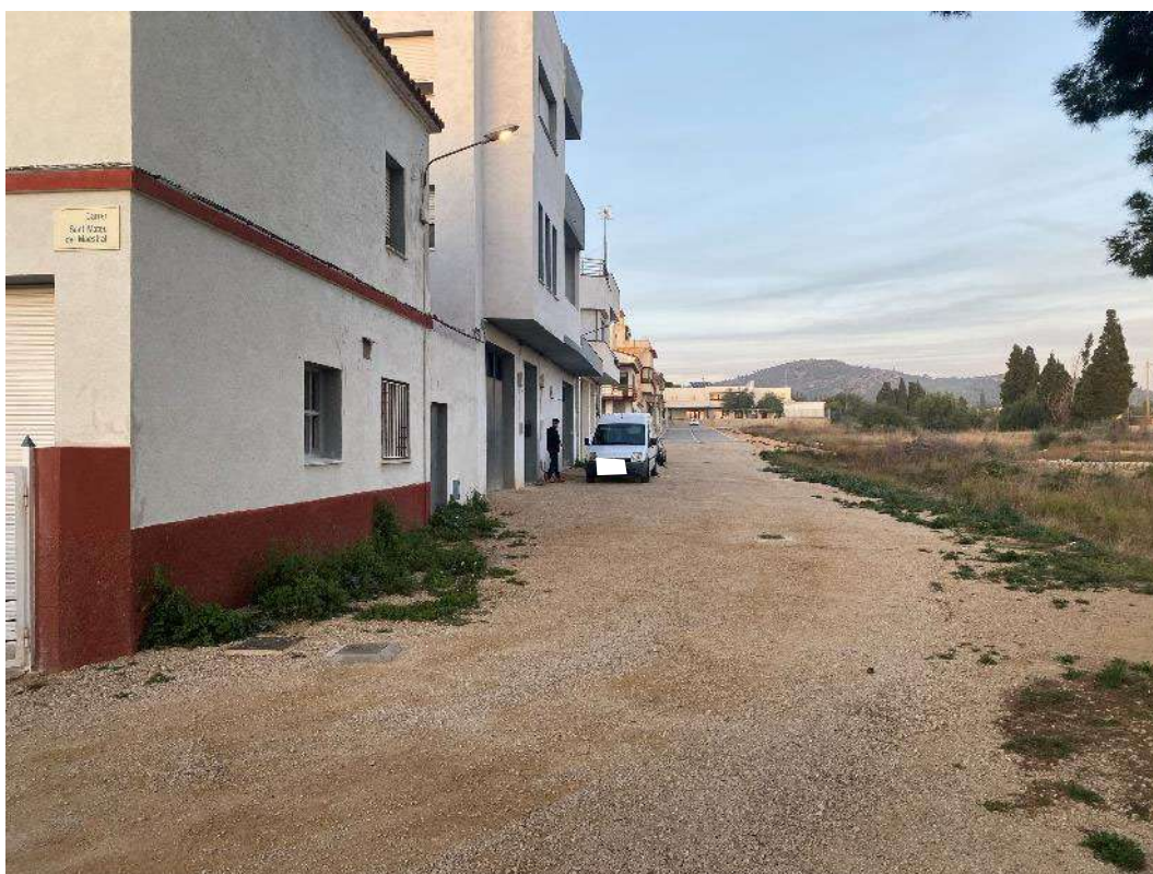
Carrer Solicru (vista de sud a nord)
