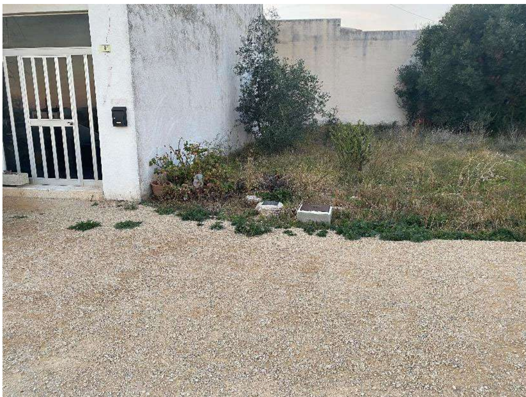
Serveis executats en la fase 1
