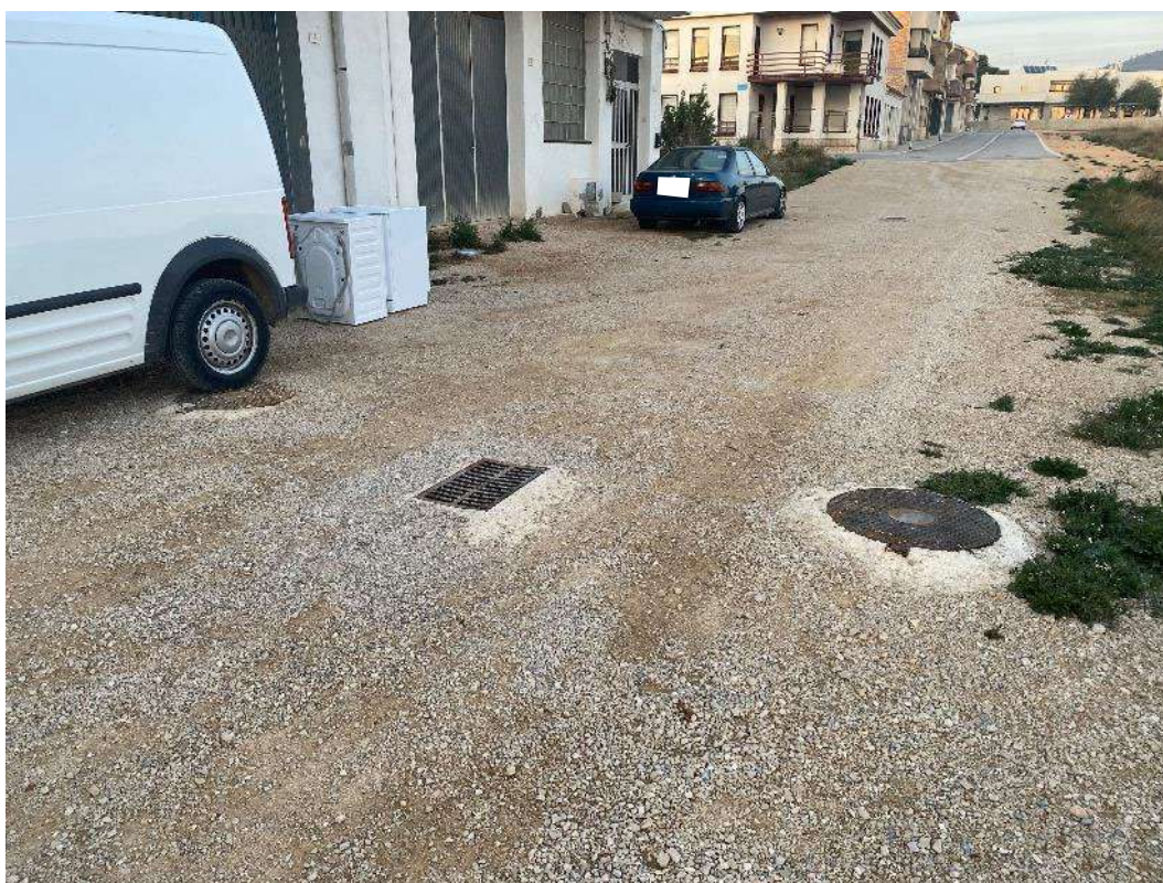
Serveis executats en la fase 1
