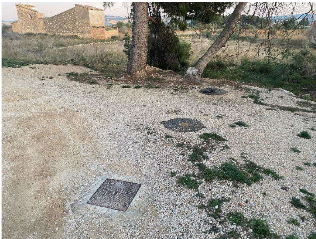
Instal·lacions existents al carrer Sant Mateu del Maestrat
