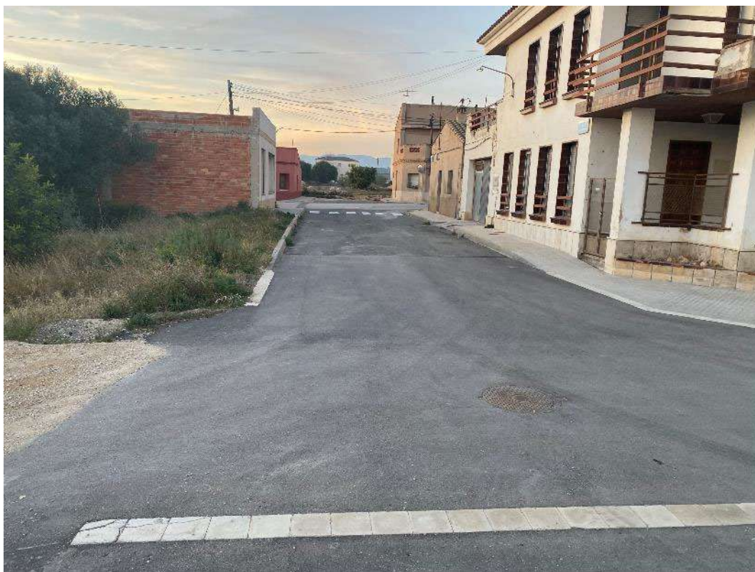
Vista carrer Sant Joan (executat en fase 1)
