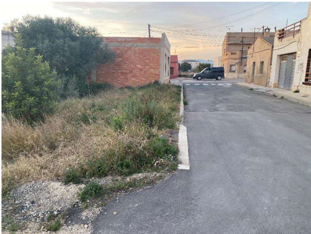
Vista carrer Sant Joan (executat en fase 1)
