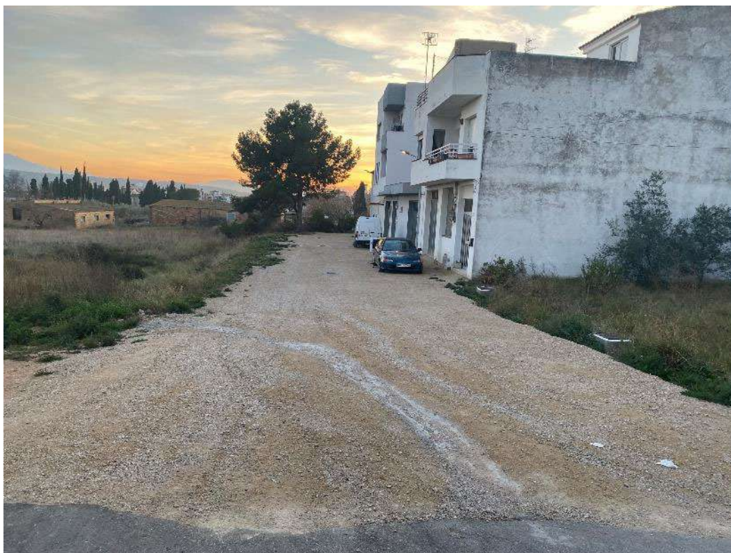
Carrer Solicru (vista de nord a sud)
