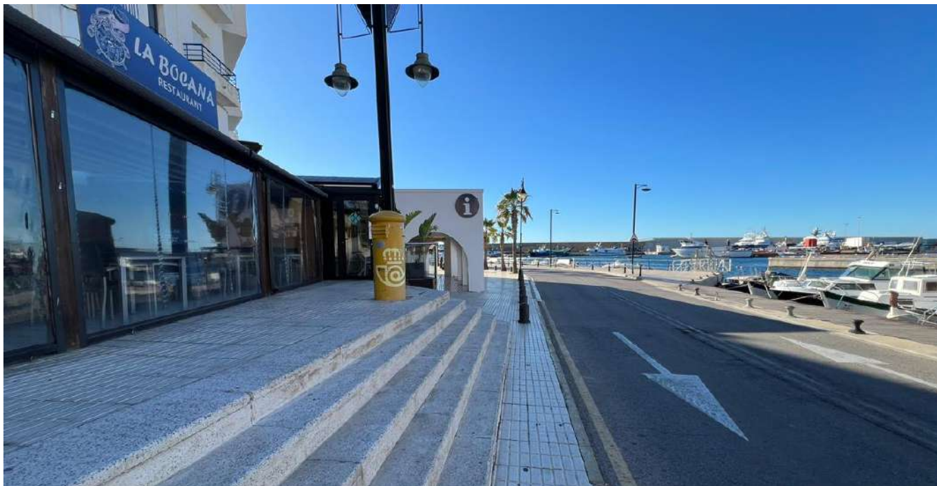
Imatge n°7. Zona escales, detall bústia a retirar.
