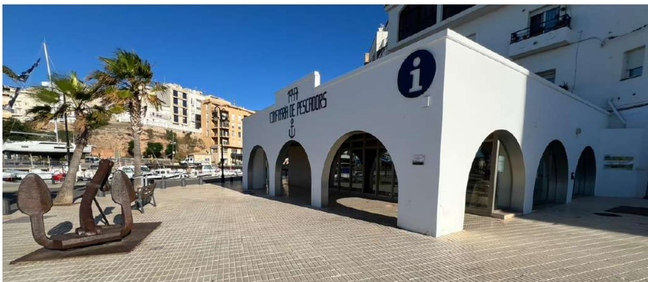
Imatge nº3. Zona de traçat de la nova canonada de clavegueram per gravetat i impulsió, zona antiga llotja
