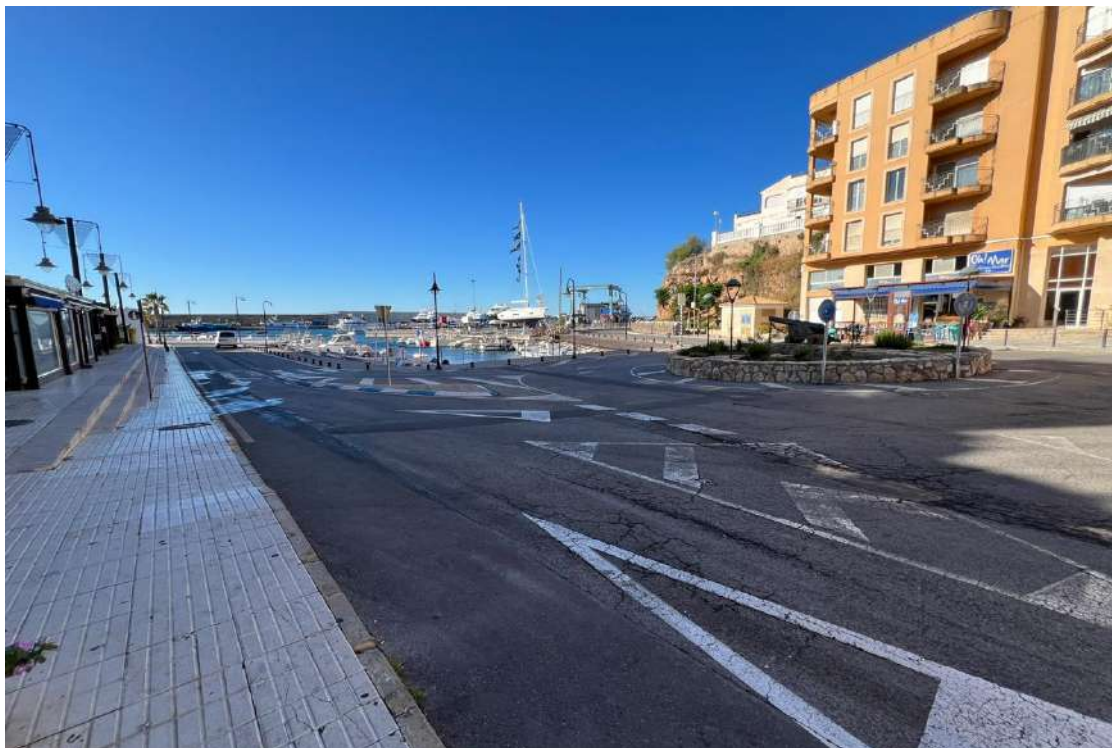
Imatge n°7. Zona de traçat de canonada, Plaça del Canó.
