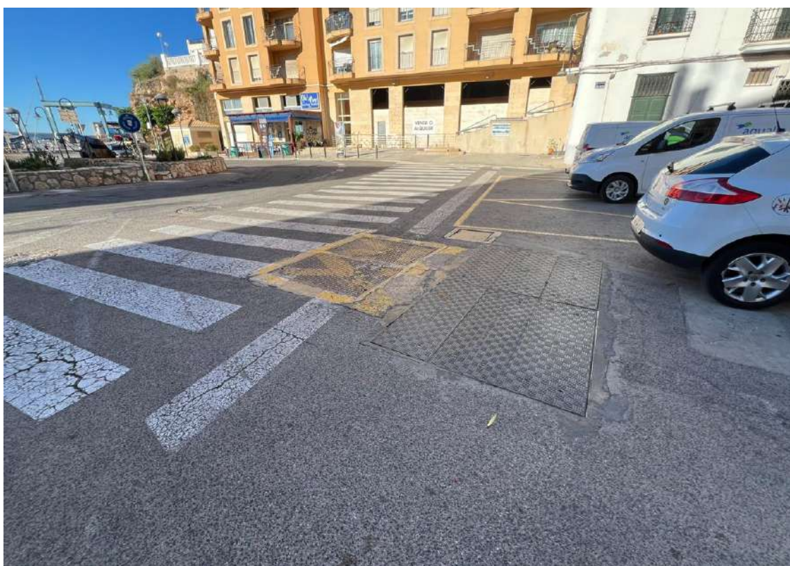
Imatge n°8. Punt de connexió, EBAR municipal, zona accés plaça del Canó des del carrer Major.
