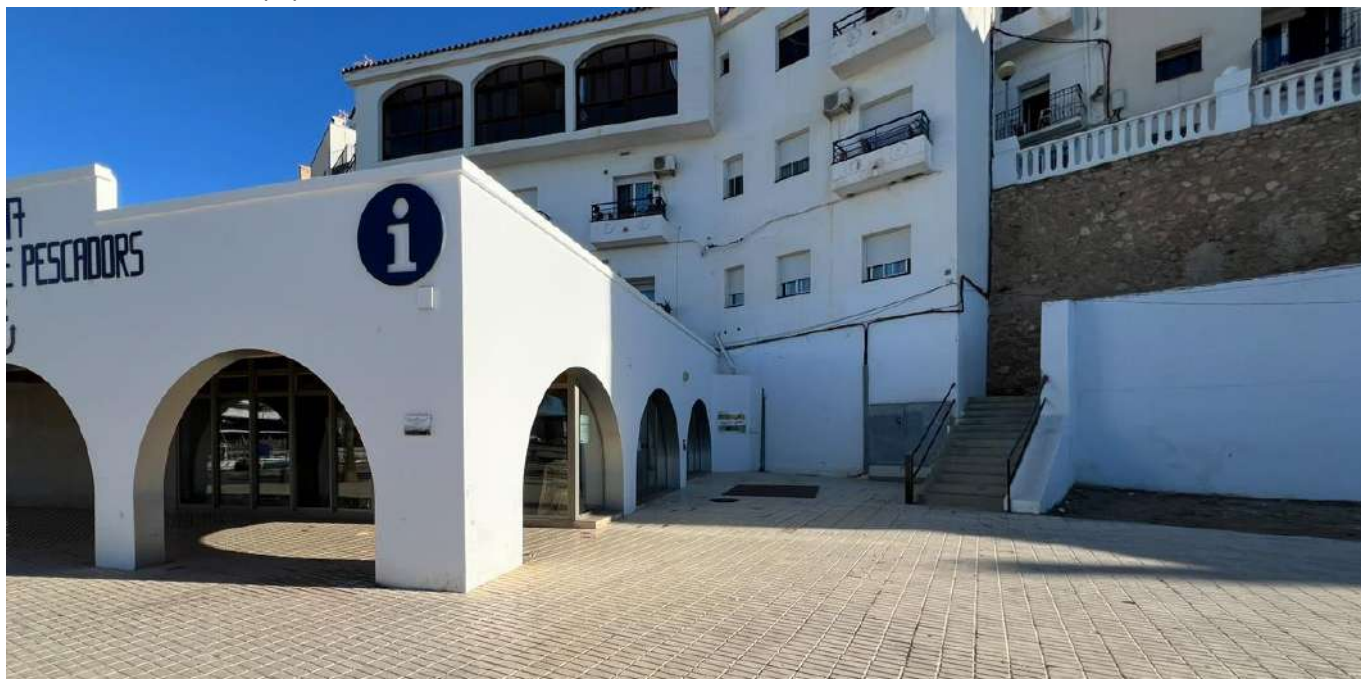
Imatge nº1. Zona on es troba ubicada l'EBAR actual, al costat de l'antiga Llotja del Peix, i espai a ubicar la nova EBAR
