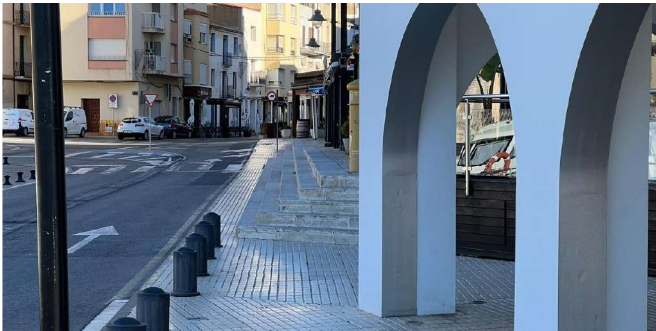
Imatge n°5. Zona traçat canonades, escales existent a enderrocar i formar nou mur.
