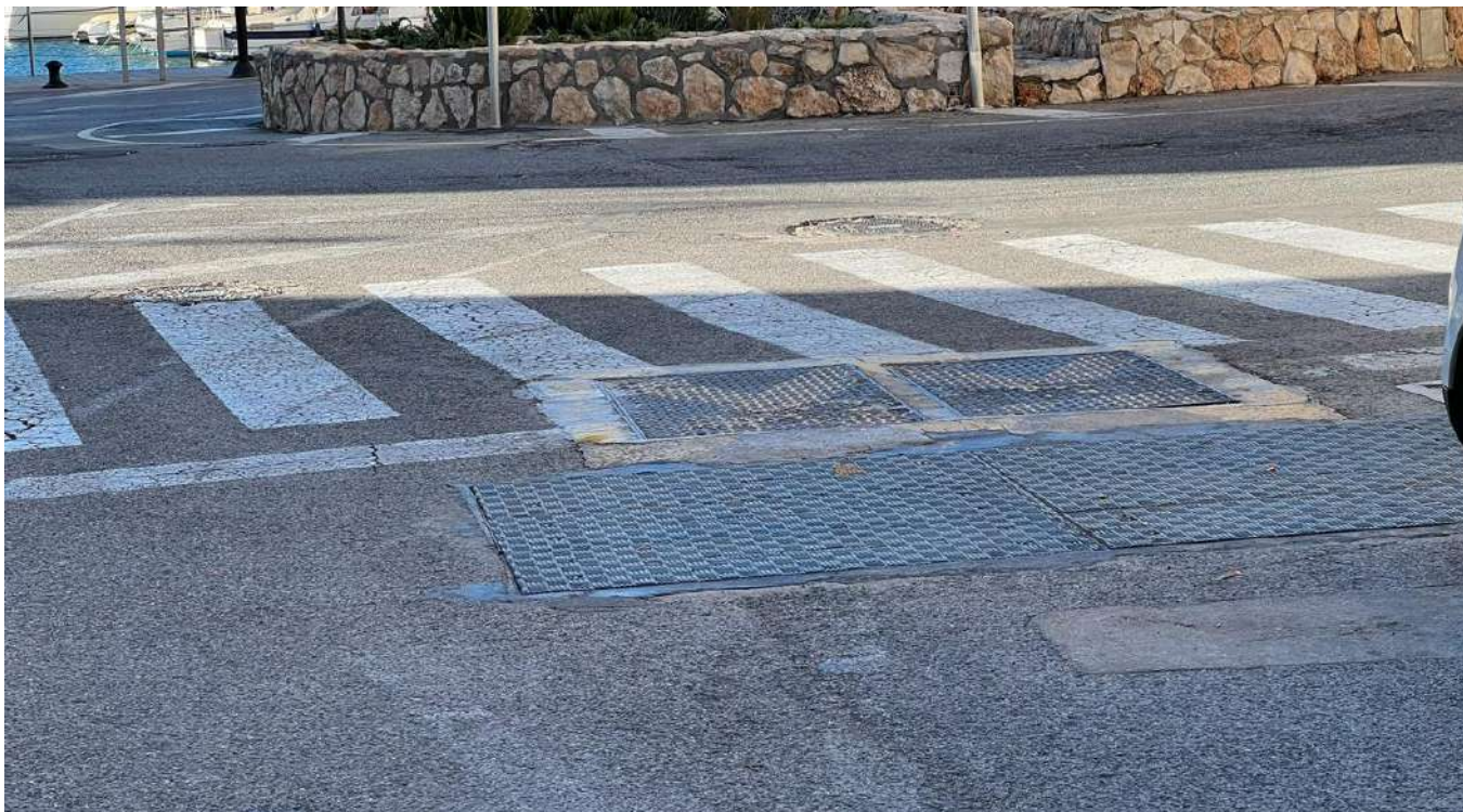
Imatge nº11. Detall ubicació EBAR existent.
