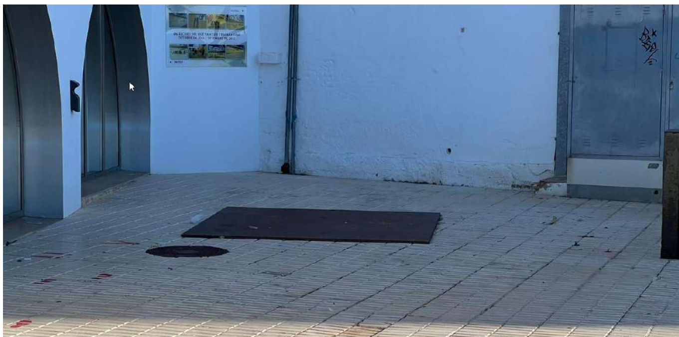
Imatge nº2. Detall EBAR existent, i ubicació del armari de connexió de la instal·lació elèctrica.
