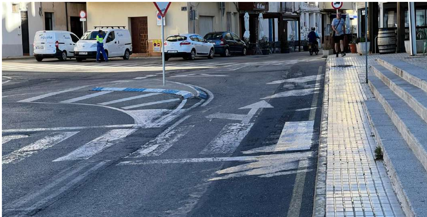
Imatge nº9. Zona final escales i anivellament en vorera, i zona ubicació EBAR municipal existent.
