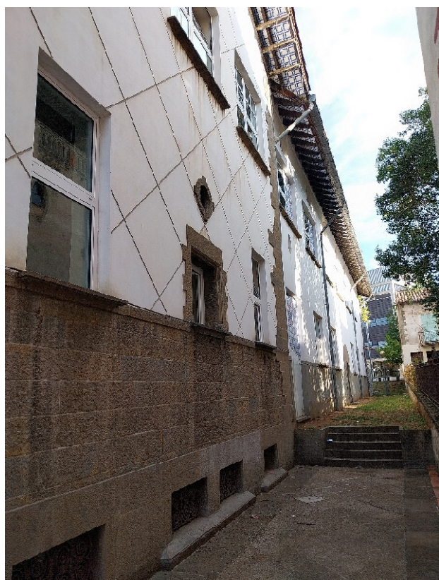
Imatge 4. Estat actual d'una de les façanes laterals de l'edifici
