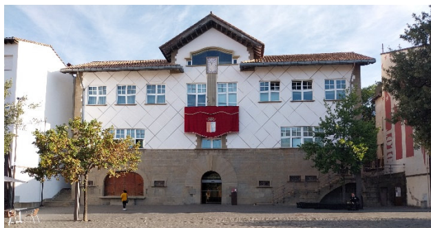
Imatge 2. Estat actual de la façana principal al Passeig Bisbe Guillaumet
