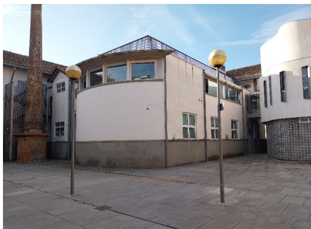
Imatge 3. Estat actual de la façana a la plaça Joanetes
