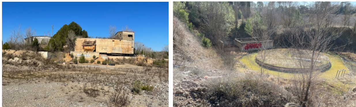
Figura 7. Estat actual de les instal·lacions. Font: Pròpia
