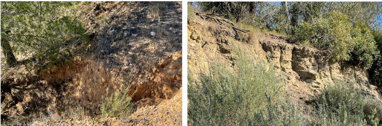
Figura 18 Talls del terreny en diversos punt en el perímetre de l'actuació. Font: Pròpia
