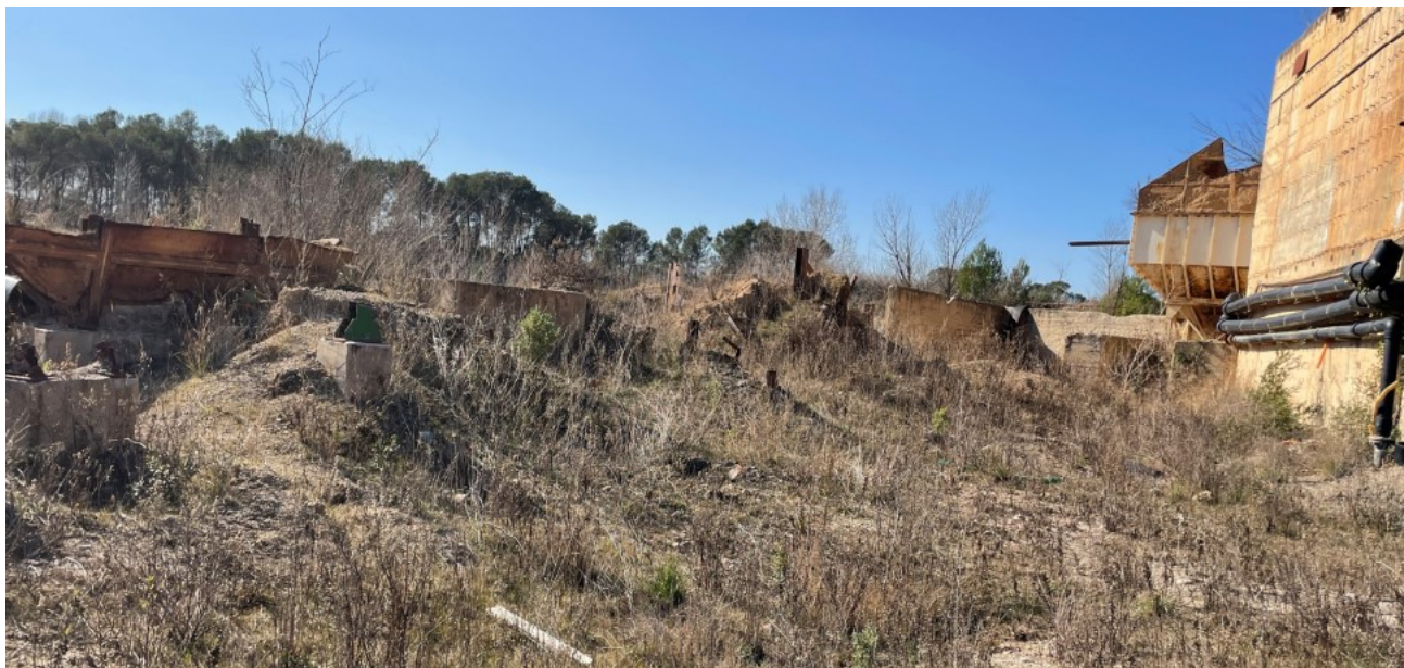
Figura 26. Conjunt d'acopis d'àrids i restes d'instal·lacions de l'activitat extractiva. Font: Pròpia
