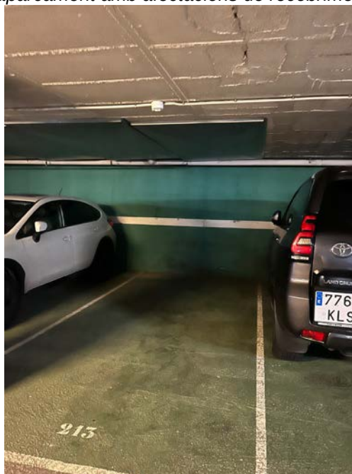
Reparació cautelar de les filtracions realitzada amb una xapa.
