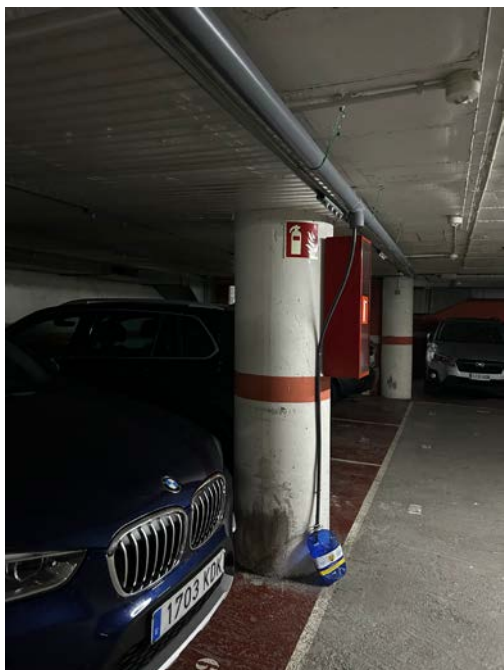
Reparació cautelar de les filtracions realitzada amb una coberta ondulada
