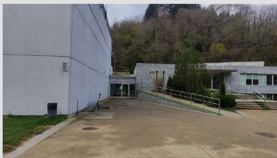
Imatges del lateral del pavelló on s'ha previst d'ubicar el nou accés i els nous vestidors.
