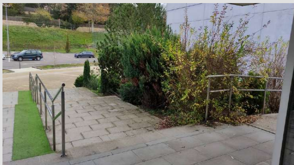
Imatges de detall dels accessos
