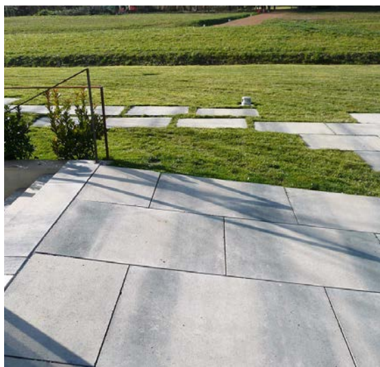
Exemple de paviment exterior amb lloses de formigó de la casa Breinco.
