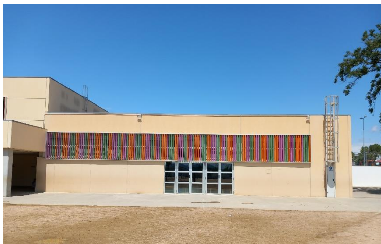
Foto 11: Façana Interior del gimnàs – Accés Escala de gat
