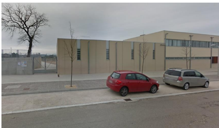
Foto 13: Façana des de l'exterior - Vial
