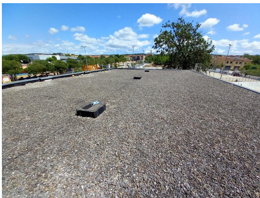
Foto 13: Vista de Conjunt de la coberta
