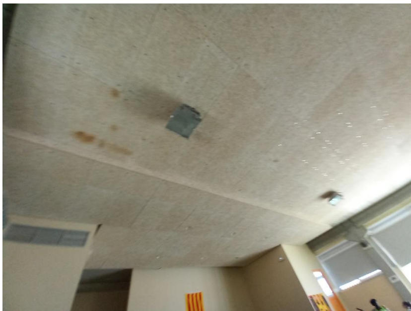
Foto 8: Taques humitat al revestiment del sostre
