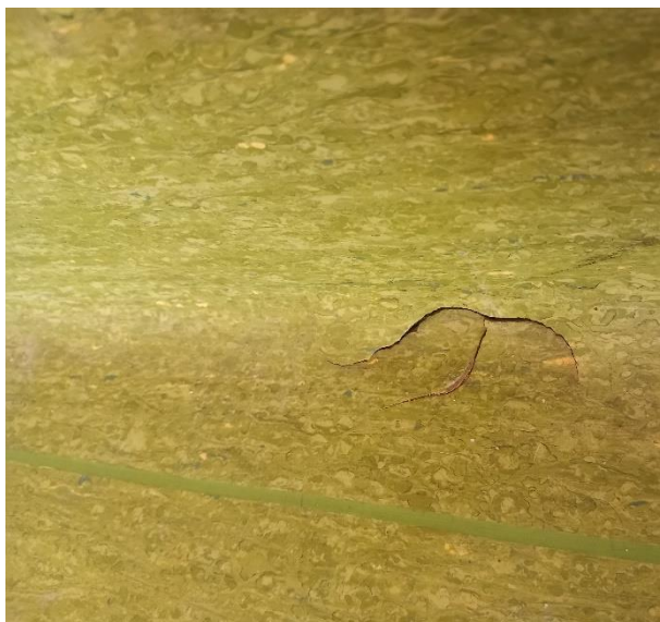
Foto 23 i 24: Detall del trencament del sòcol de PVC
