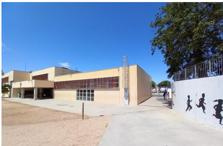
Foto 12: Façana lateral i accés rodat
