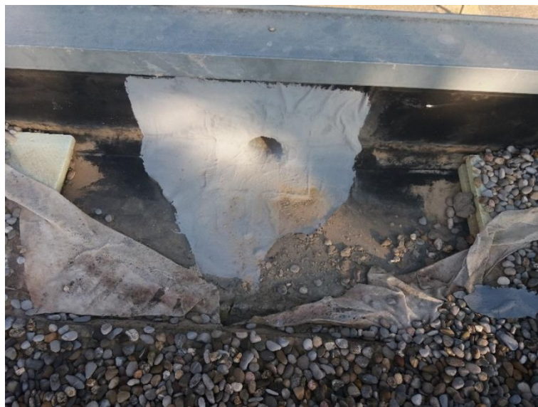
Imatge 2: Reparació embocadura EPDM a baixant.
