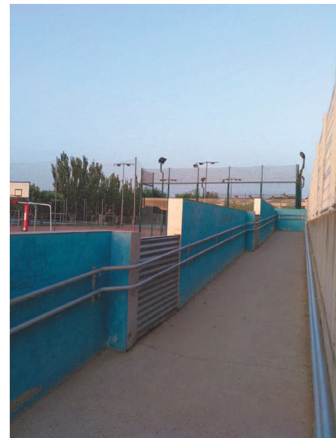
FOTO 10. Rampa accés a col·legi annex.
