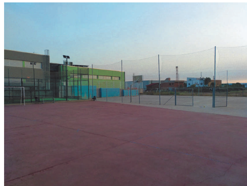
FOTO 05. Pista annexa a pista a cobrir.
