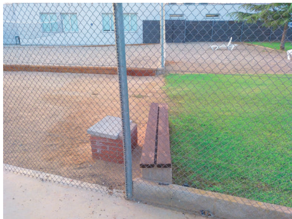
FOTO 03. Elements a enderrocar.
