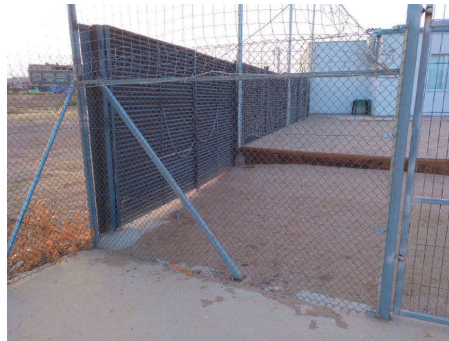
FOTO 01. Porta accés rodat al complex.
