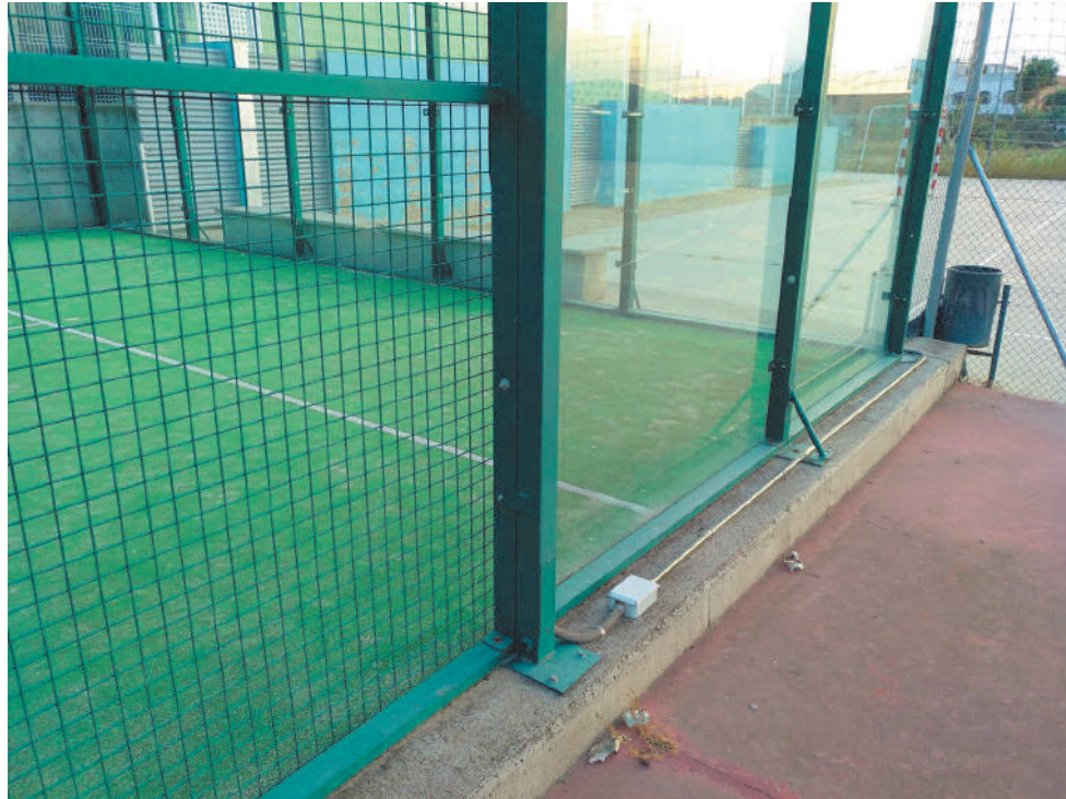
FOTO 11. Paviment pista de pàdel a enderrocar.
