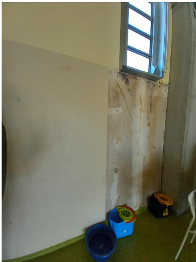
Foto 7: Deteriorament del revestiment de la paret.
