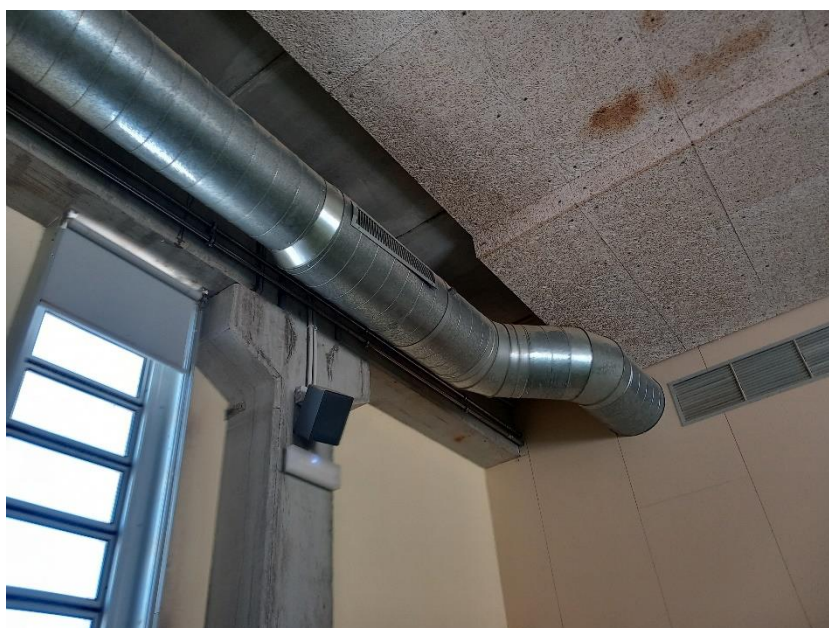
Foto 6: Filtracions de Coberta. Aigua a la columna i al sostre
