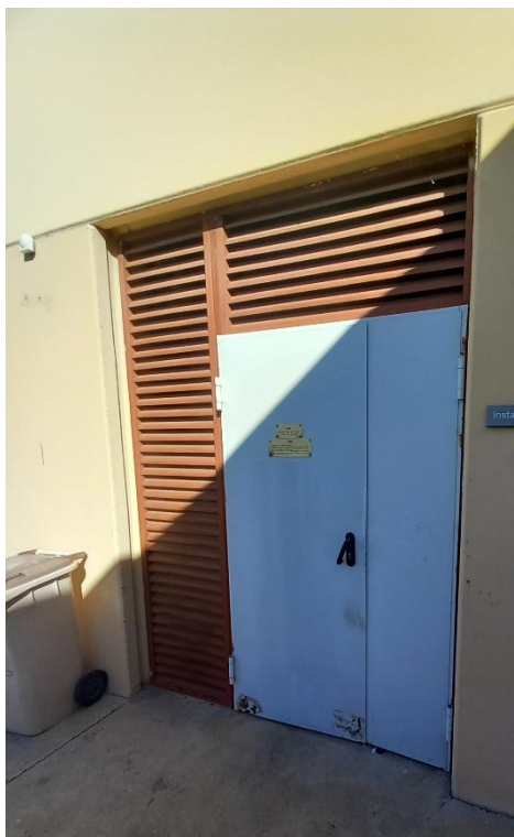
Fotografia 4: Porta actual de la sala de calderes
