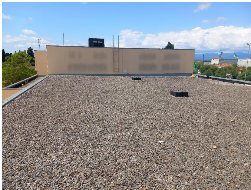
Foto 14: Vista de conjunt de la coberta
