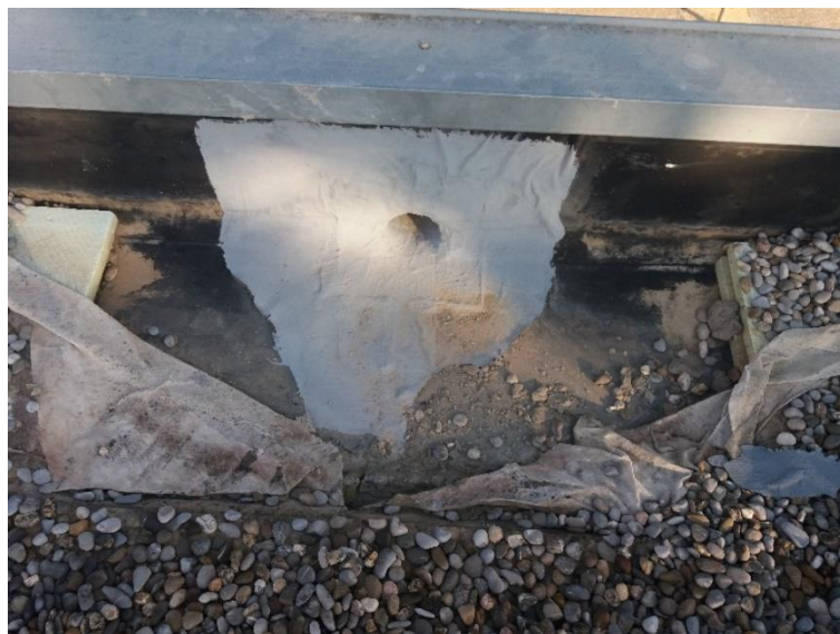
Imatge 2: Reparació embocadura EPDM a baixant.
