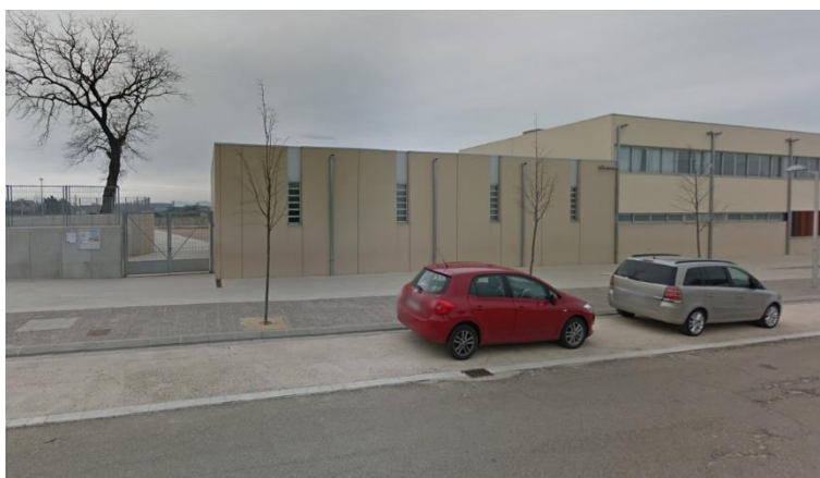
Foto 13: Façana des de l'exterior - Vial
