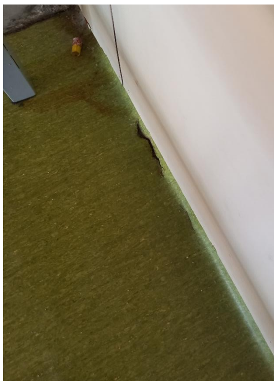
Foto 23 i 24: Detall del trencament del sòcol de PVC
