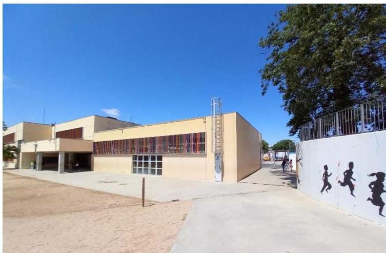
Foto 12: Façana lateral i accés rodat
