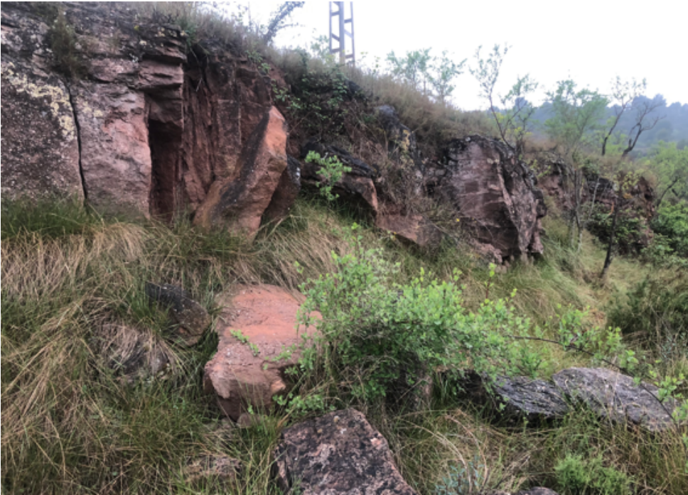
Fotografies dels afloraments de roca localitzats en els talussos del solar d'estudi.
