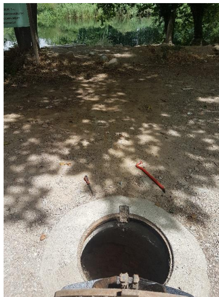
Imatge 2. Darrer pou de registre abans del punt d'abocament.
