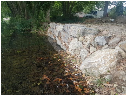
Imatge 1. Punt de connexió del sobreexidor al riu Ter. d'abocament.
