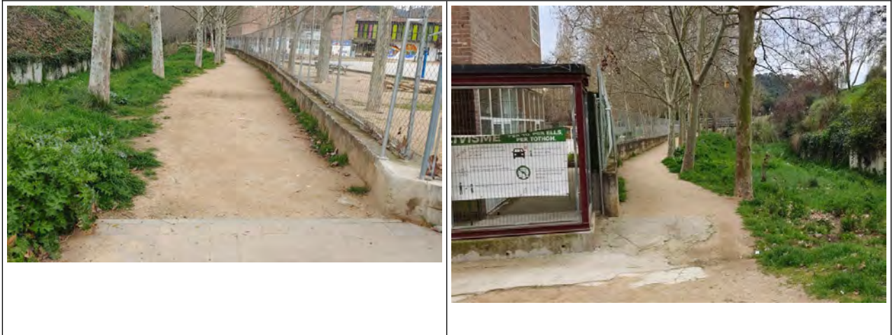
Fotos generals de l'estat actual de l'àmbit de les obres
