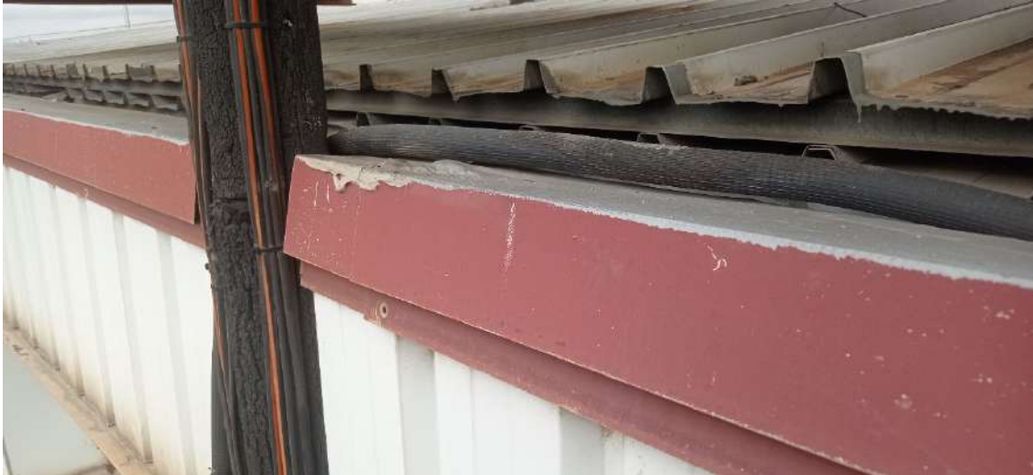
REMAT CORONAMENT FAÇANA-CANAL
