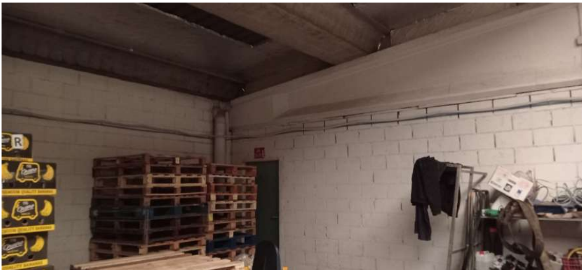
BIGA DELTA RECOLZAMENT PILARS INTERIOR NAU
