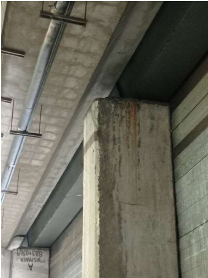
VISTA RECOLZAMENT CANAL
