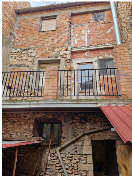
Estat actual façana pati
