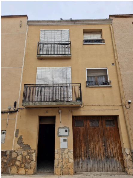
Estat actual façana Carrer Bassa
