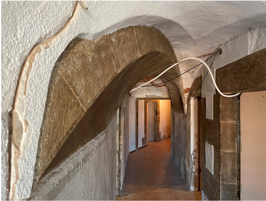
Arc rebaixat de pedra en el corredor de l'entresol
