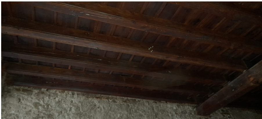
Sostre catalogat de planta primera: forjat mixt amb estructura de fusta i formigó (revestit amb vernís ignífug)
