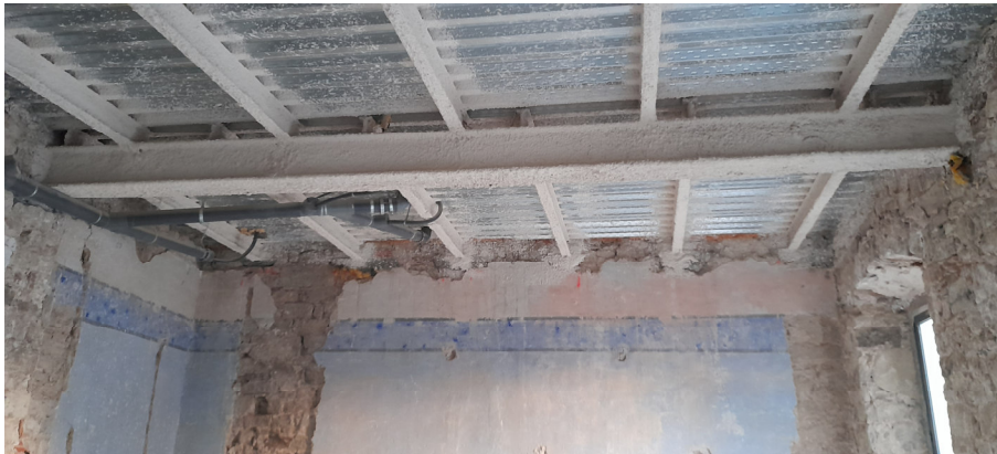
Sostre de planta primera: forjat mixt d'estructura metàl·lica i formigó ('estructura principal ignífuda amb perlita)
