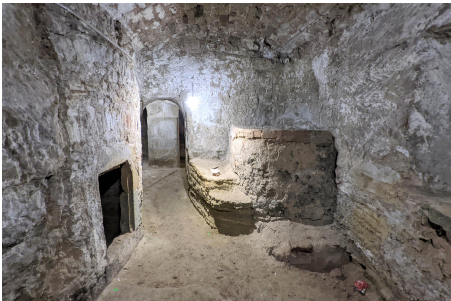
Soterrani picat a la pedra
