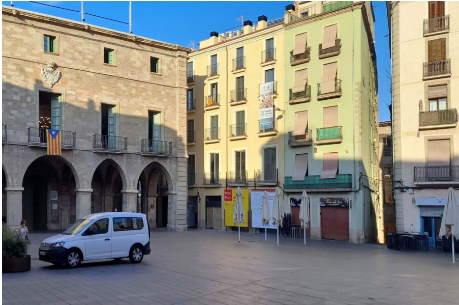
Estat actual de la Casa Fàbregas
