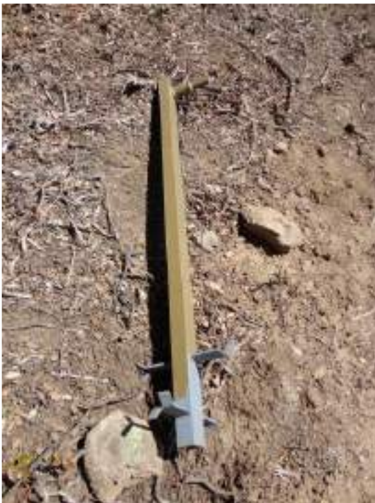
Imatge 4. Model de peu de fixació de tanca de camí, de secció rectangular i amb pany metàl·lic del model Alt Empordà, i amb les peces transversals a la base que li donaran estabilitat.
