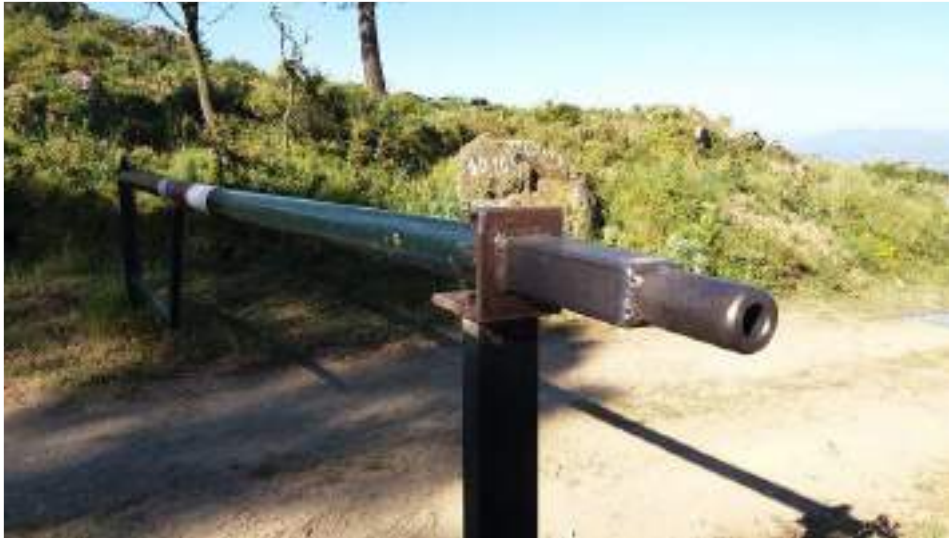
Imatge 5. Model de nou èmbol a instal·lar en tanques amb el pany forçat o defectuós, abans de pintar.
