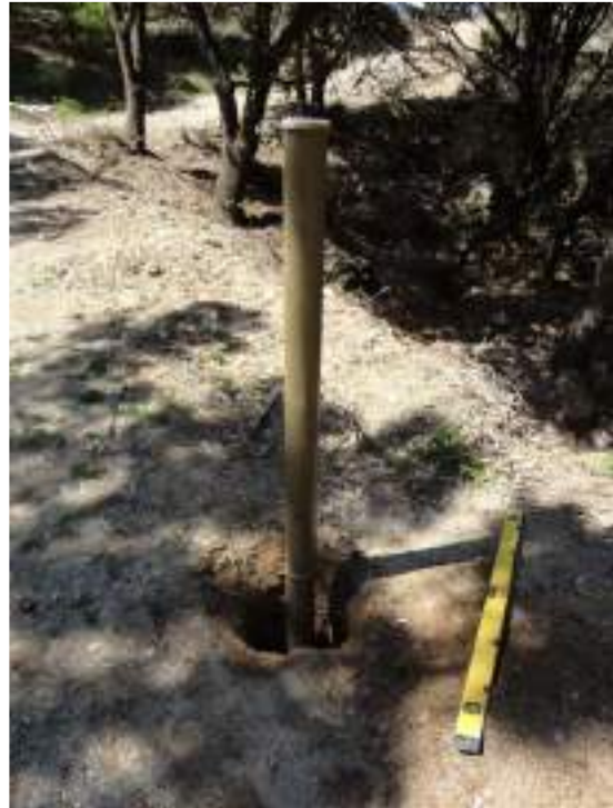
Imatge 3. Model de peu de subjecció de la tanca, de secció circular, amb les peces transversals a la base que li donaran estabilitat.
