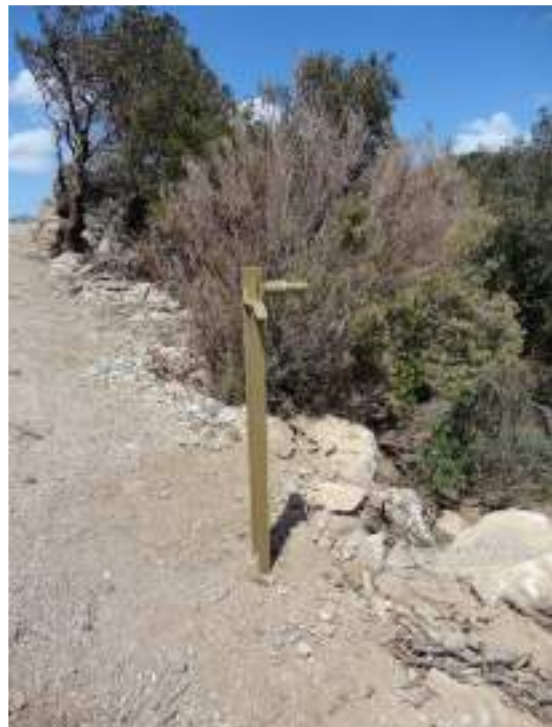
Imatge 4. Model de peu de fixació de tanca de camí, de secció rectangular i amb pany metàl·lic del model Alt Empordà, i amb les peces transversals a la base que li donaran estabilitat.
