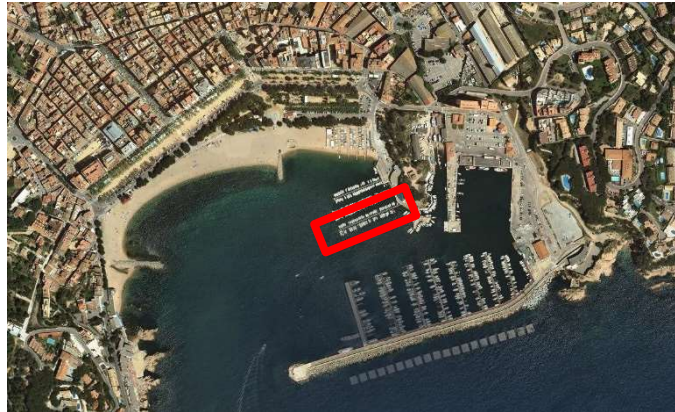
Vista aèria ubicació de les obres de la situació del pantalà
