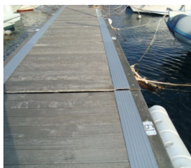
Vista unions dels trams de passarel·la (principi)
