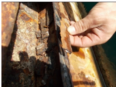
Detalls perfils de ferro i ancoratges del tren de fondeig
