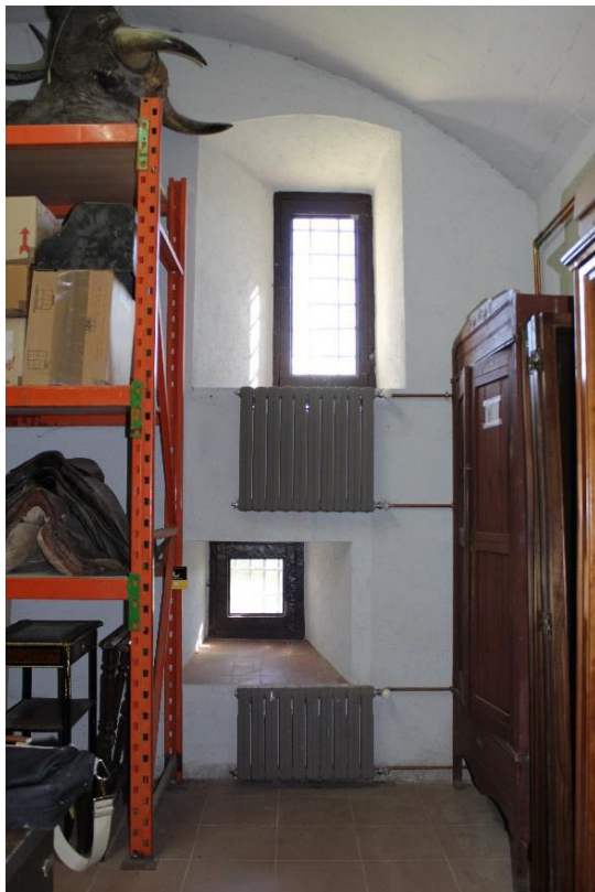
Vista parcial del mur est on es veuen les finestres i els radiadors, així com part del mobiliari existent.
