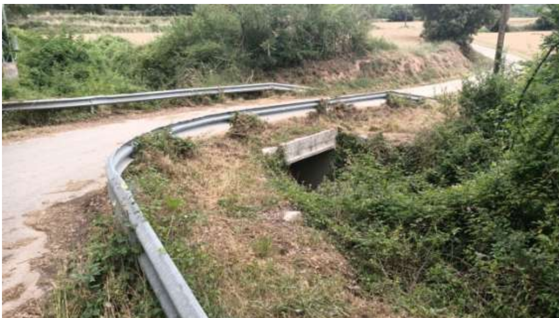
Camí del Clot. Pas obra de drenatge
