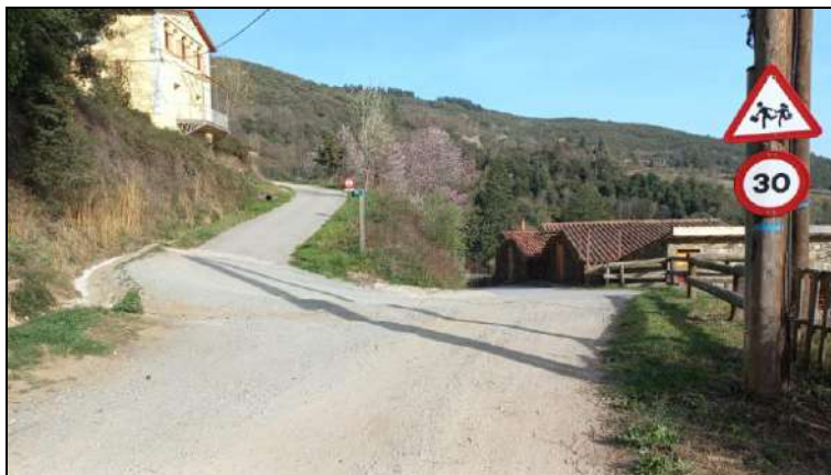
Imatge 1. Àmbit del tram A. Corba a pavimentar-se.
