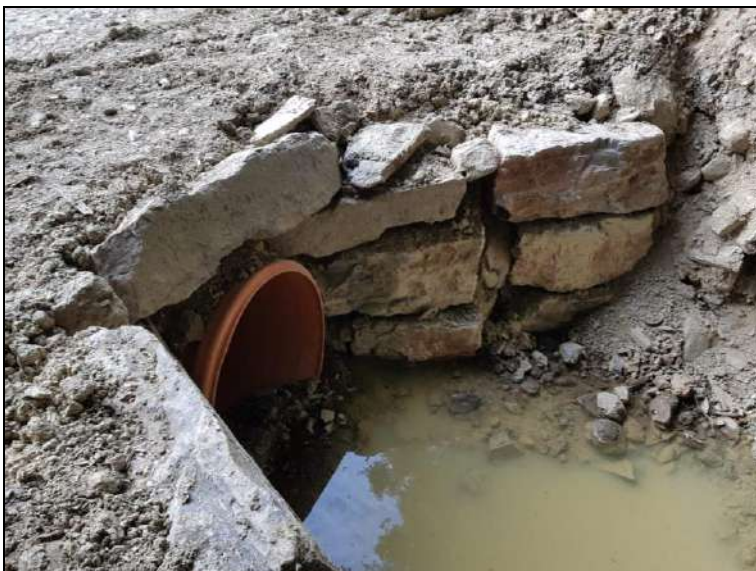
Imatge 11. Exemple d'escullera en entrada d'obra de drenatge
