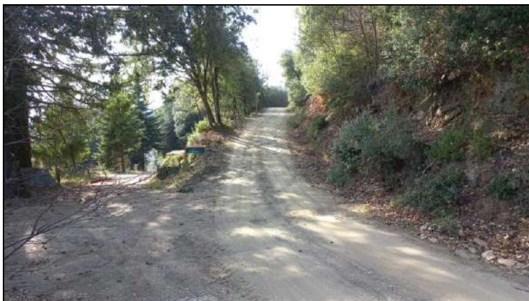
Imatge 9. Baixador a pavimentar del tram I. Al final del mateix, es preveu ubicar l'obra de drenatge transversal.
