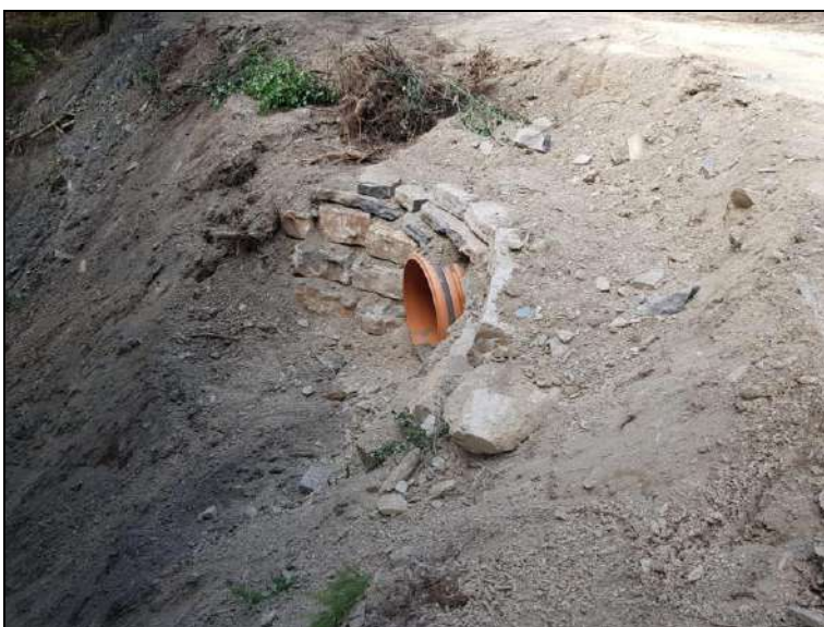
Imatge 12. Exemple d'escullera en sortida d'obra de drenatge
