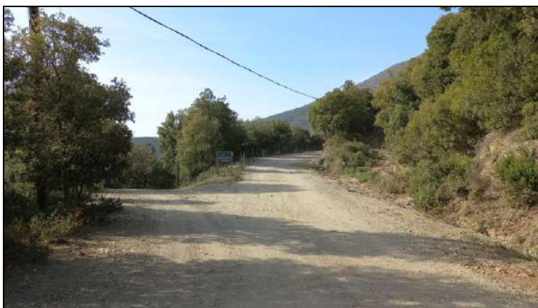
Imatge 10. Àmbit on es preveu ubicar l'obra de drenatge transversal.
