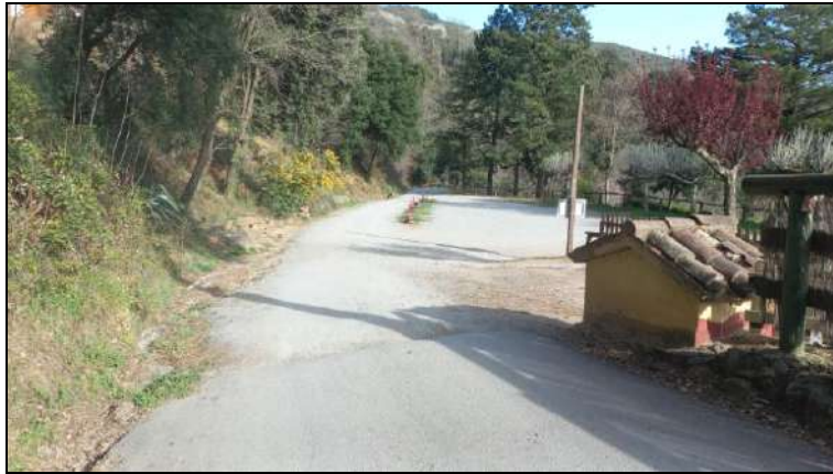
Imatge 2. Àmbit del tram B, entre els dos trams pavimentats.
