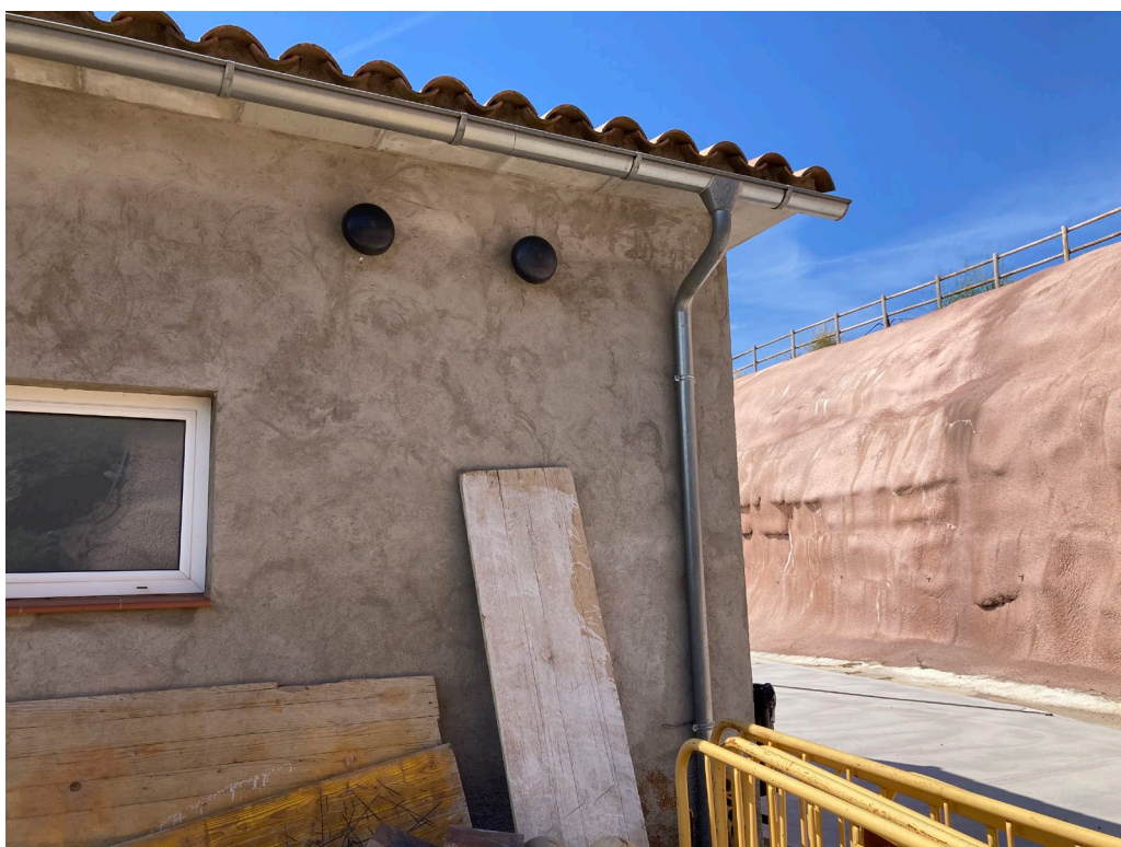
Caneló i baixant de la façana posterior (costat nord)
