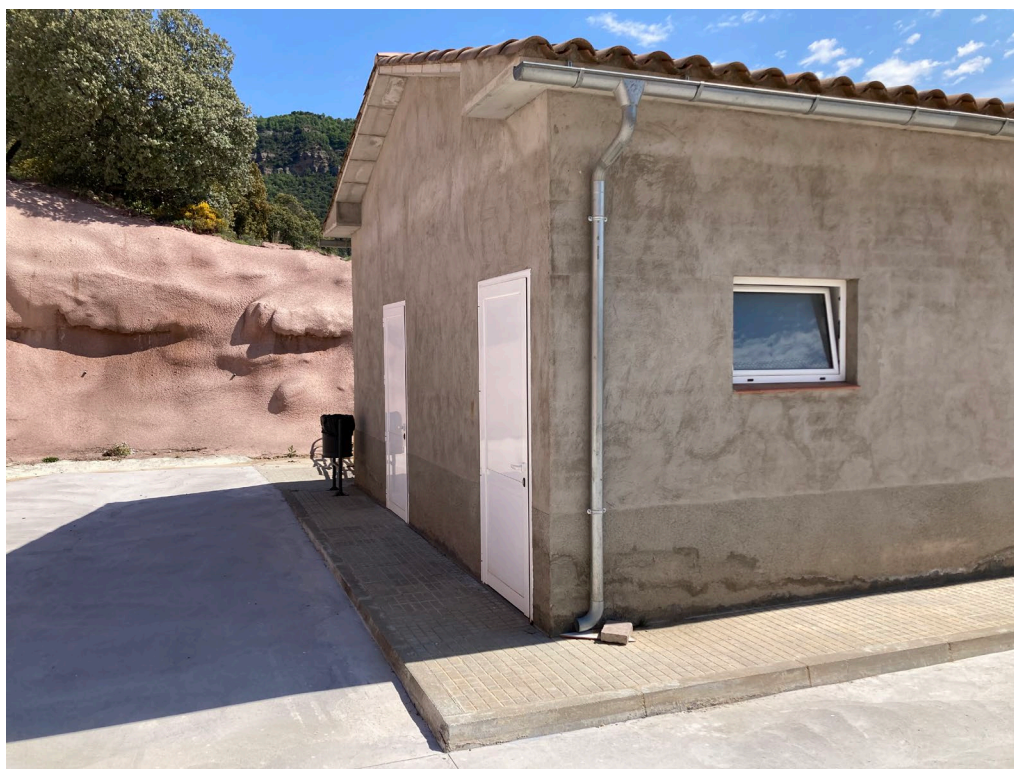
Caneló i baixant de la façana principal (costat nord)
