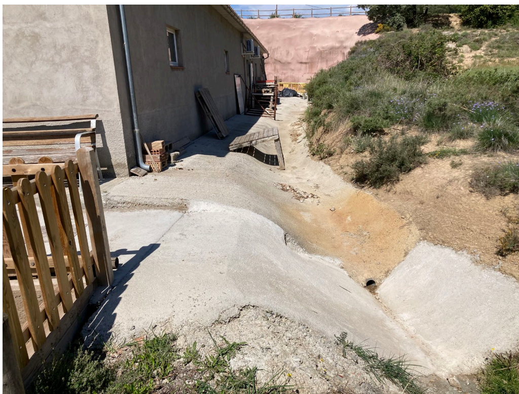
Cuneta i zona d'emplaçament de l'arqueta amb sorrer
