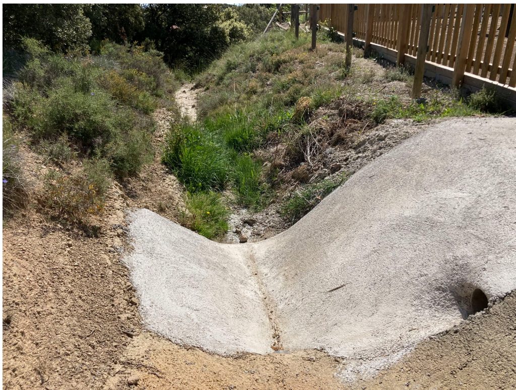
Desguàs de la cuneta i talús posterior. S'observa l'espai per a executar la rasa amb el col·lector soterrat
