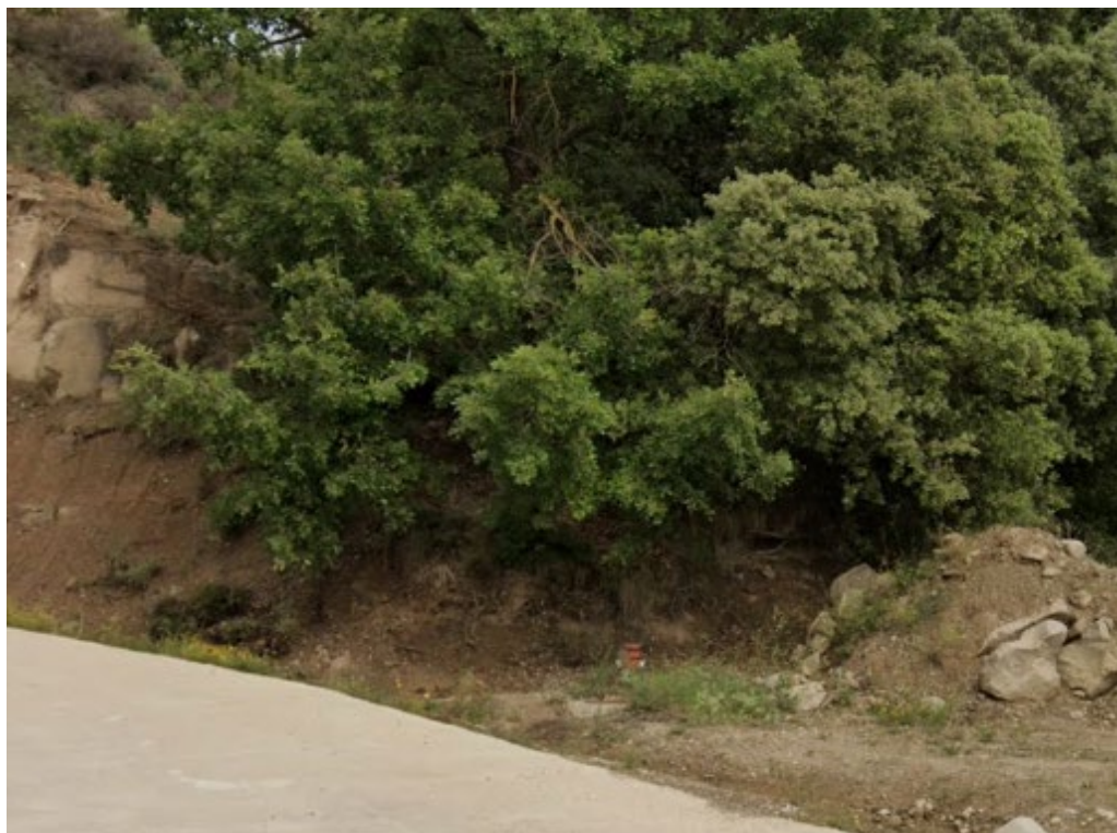
Detall del punt de sortida del dipòsit. S'observa un hidrant aeri
