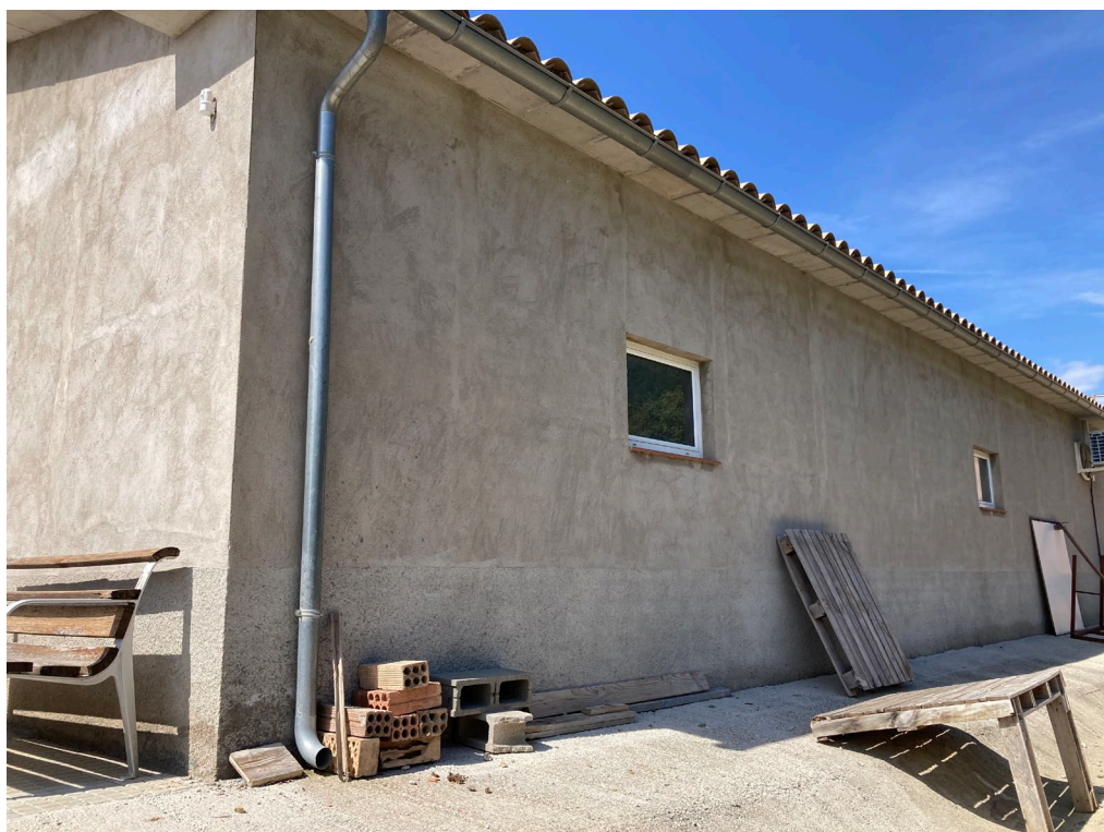
Caneló i baixant de la façana posterior (costat sud)
