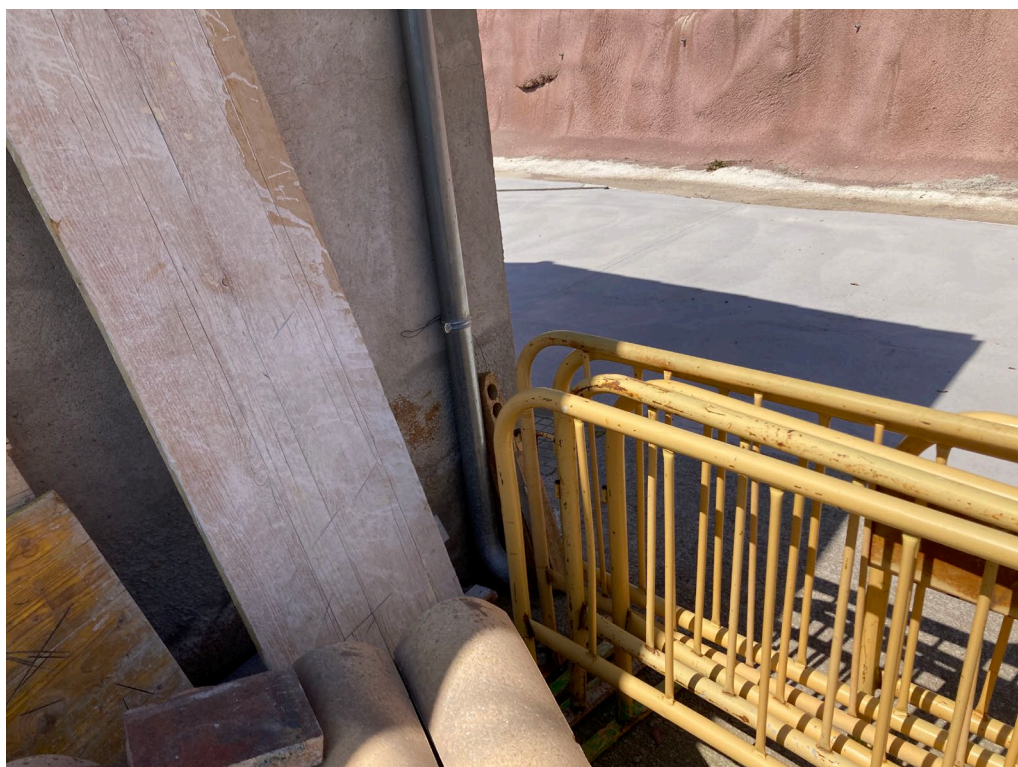
Baixant de la façana posterior (costat nord)
