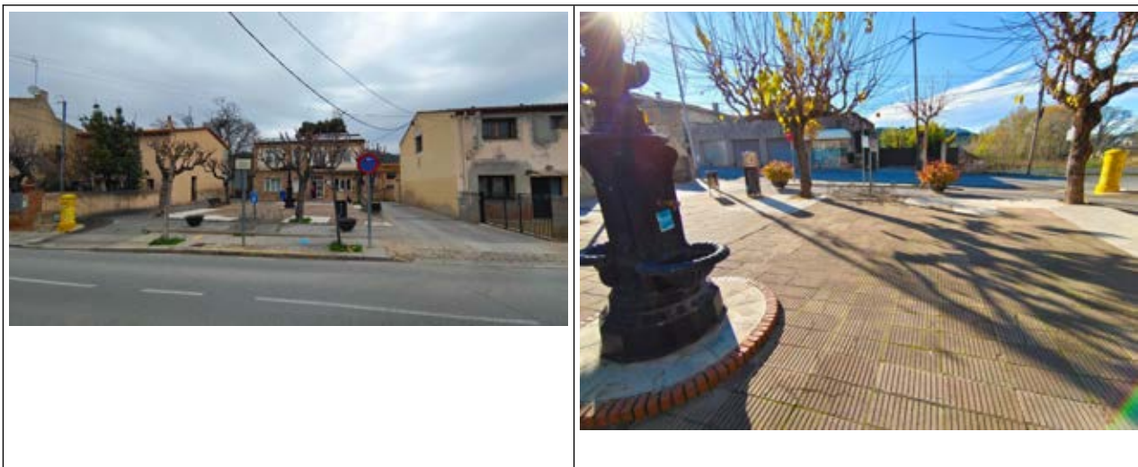
Fotos generals de l'estat actual de l'àmbit de les obres
