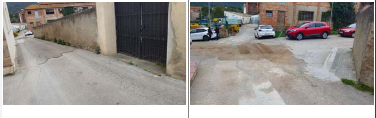
Fotos de detall de l'estat actual de l'àmbit de les obres
