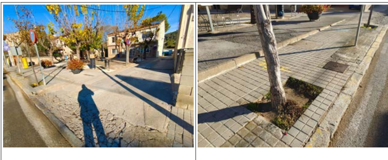
Fotos de detall de l'estat actual de l'àmbit de les obres
