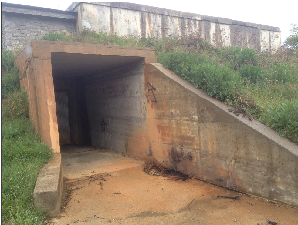
Foto 2: Ubicació de l'edifici de filtratge (costat dret de l'entrada a la sala de vàlvules). Costat est del dipòsit.
