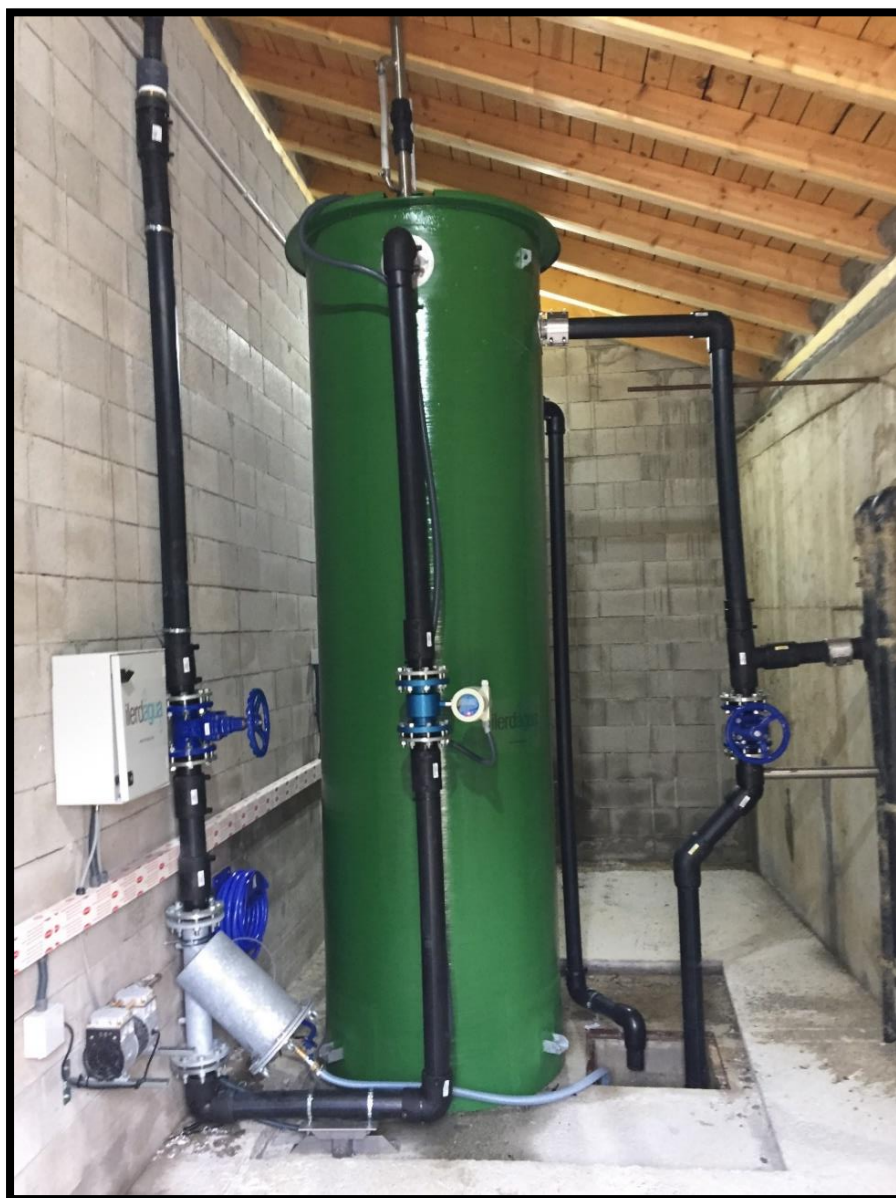
Il·lustració 1. Exemple de filtre ILF300 instal·lat en una potabilitzadora per a l'eliminació de terbolesa.
