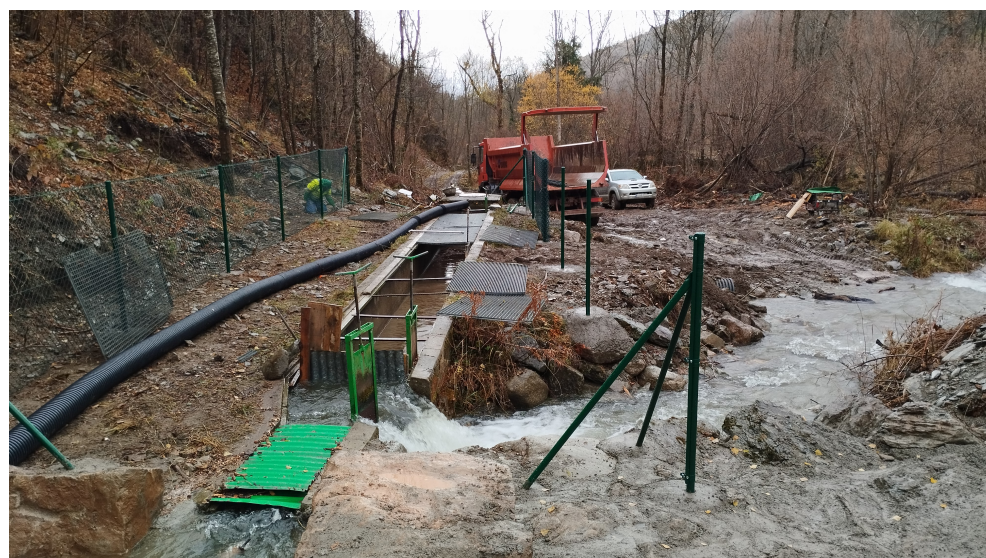
Obres d'execució de la millora de la captació d'aigua potable (tardor de 2023)
