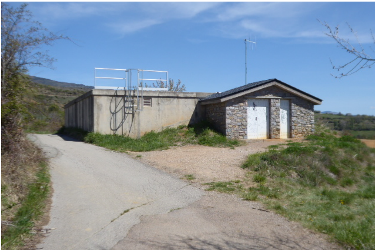
Dipòsit i caseta de cloració i valvuleria d'Olopte
