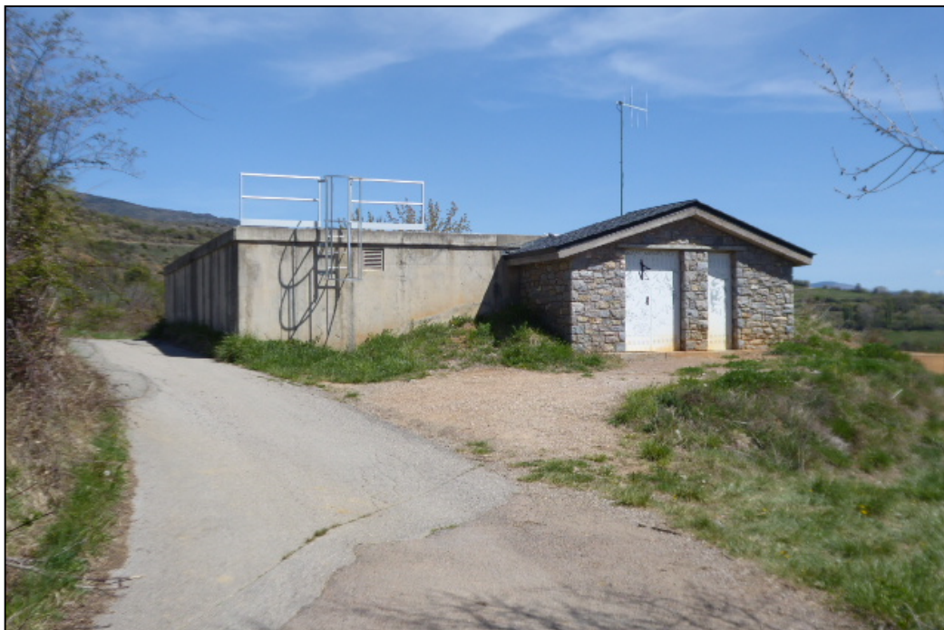
Foto 1: Dipòsit i caseta de cloració i valvuleria d'Olopte: Façana sud.
