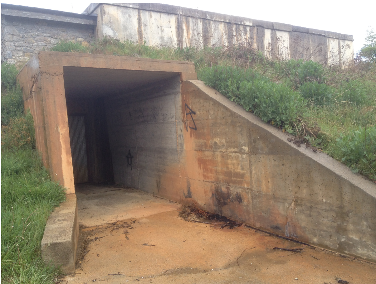
Ubicació de l'edifici de filtratge (costat dret de l'entrada a la sala de vàlvules)
