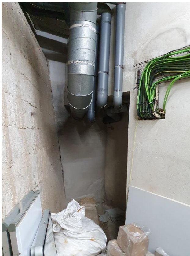
Muntant instal·lacions de planta soterrani fins planta semisoterrani.
