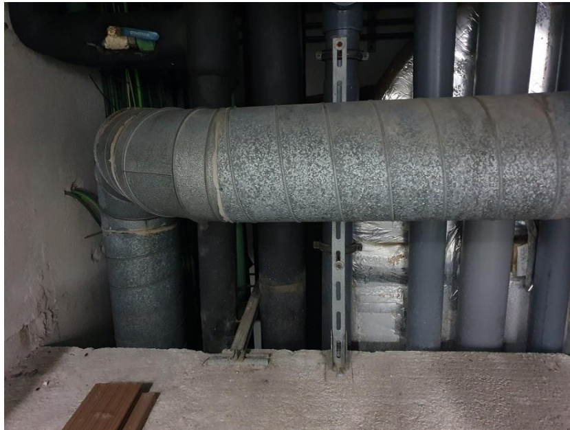
Muntant d'instal·lacions que discorre de planta semisoterrani fins planta soterrani.
