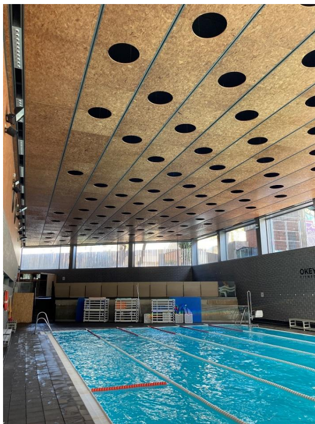
Vista general de l'espai piscina.
