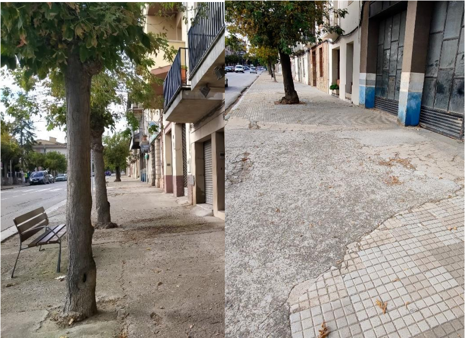
Figura 4. Voreira sobre canonada a canviar. S'observa mobiliari i canvis en material panot-formigó (Carrer Doctor Bayés)
