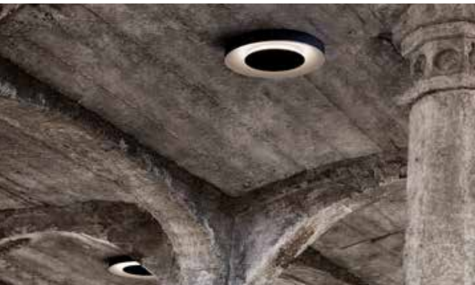
Soffitto, Plafond , Techo - P. 14
