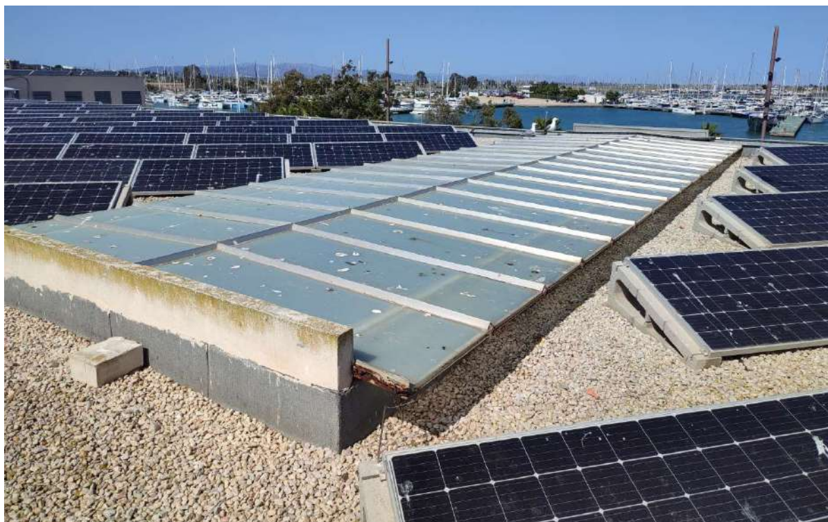
Claraboia existent a substituir CL 2
