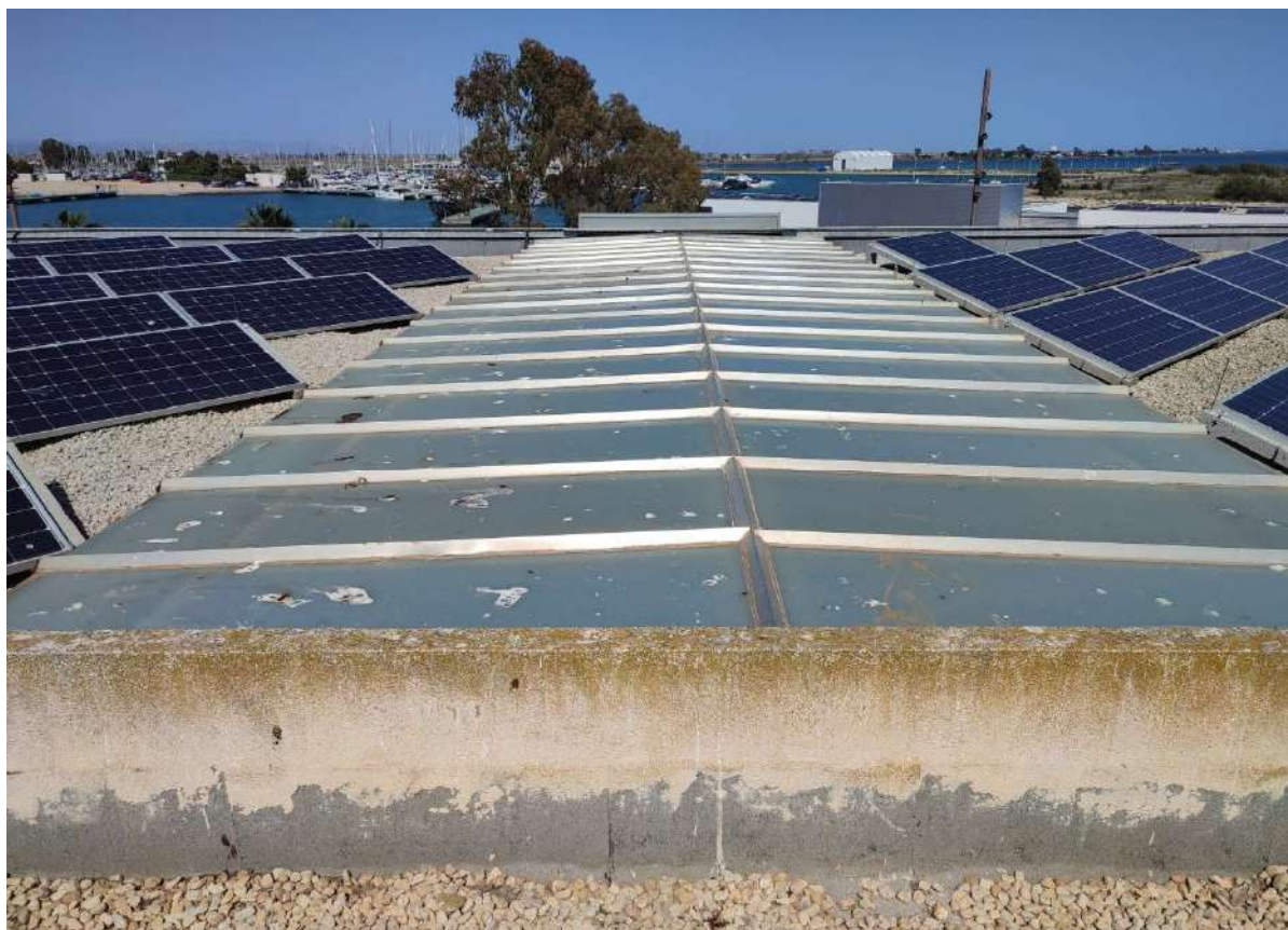
Claraboia existent a substituir CL 1
