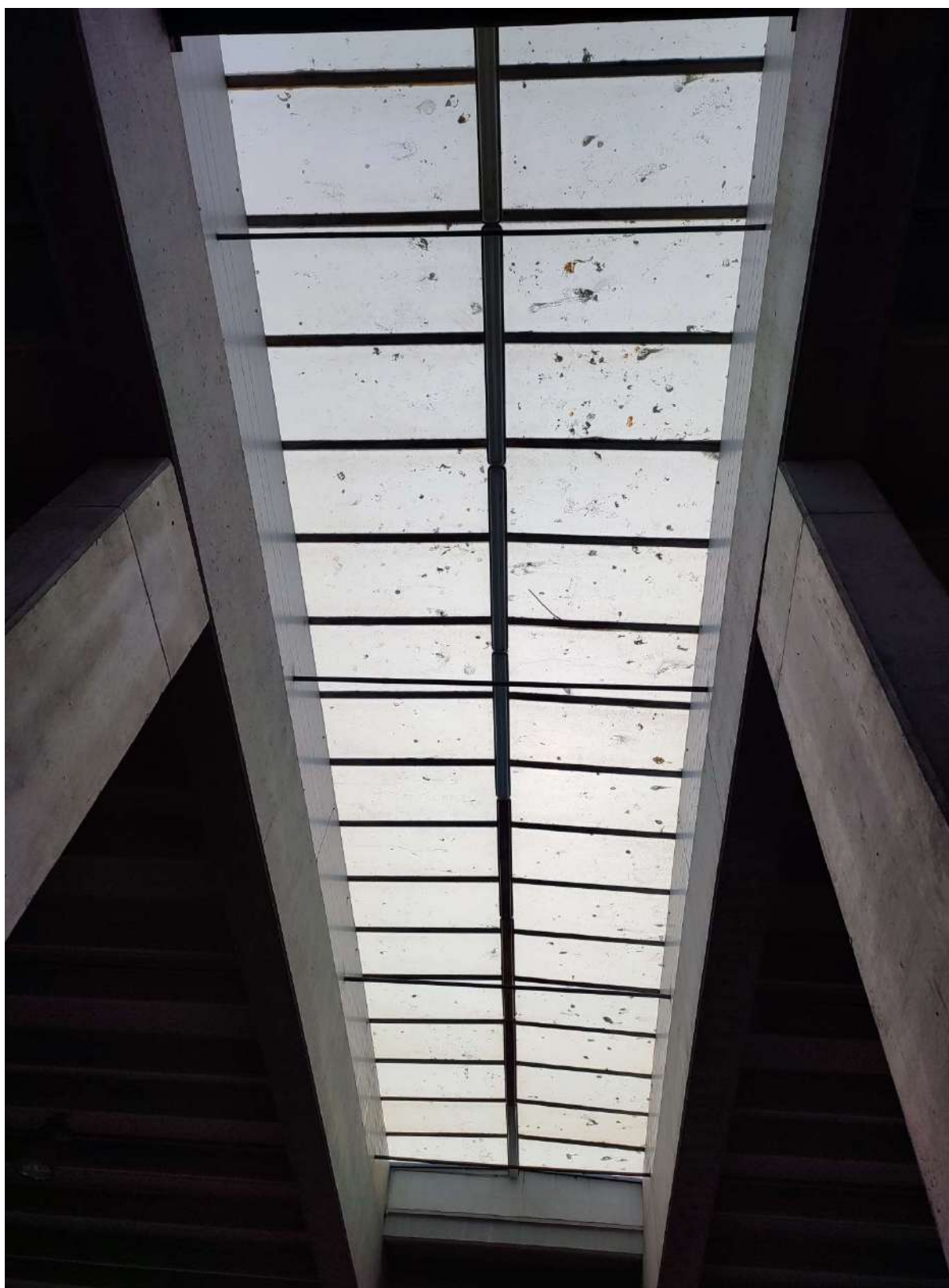
Vista inferior claraboia a substituir
