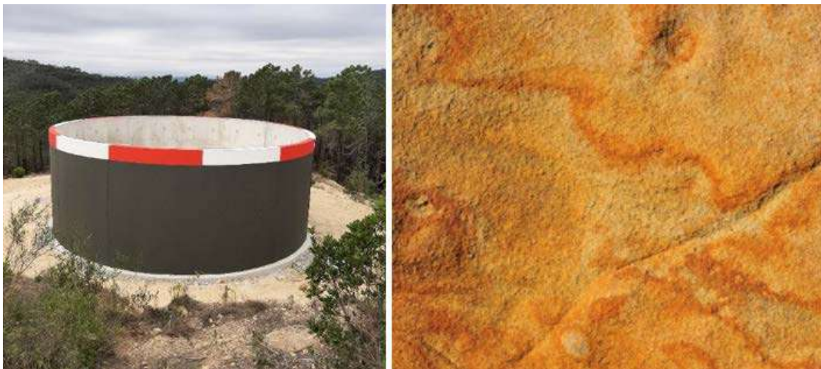
Imatge 29: Mostra del pintat d'arlequinat i del color proposat en el punt d'aigua.
