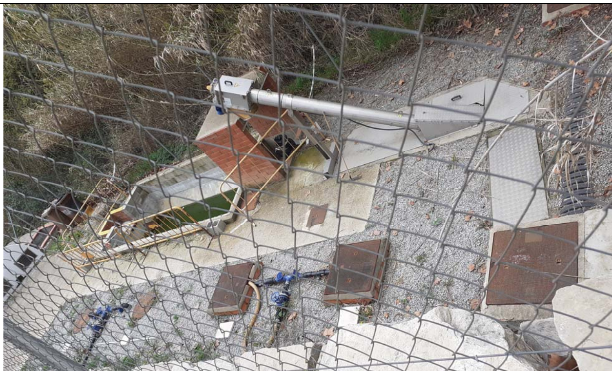
Foto 6. .Vista general de tota l'EDAR
