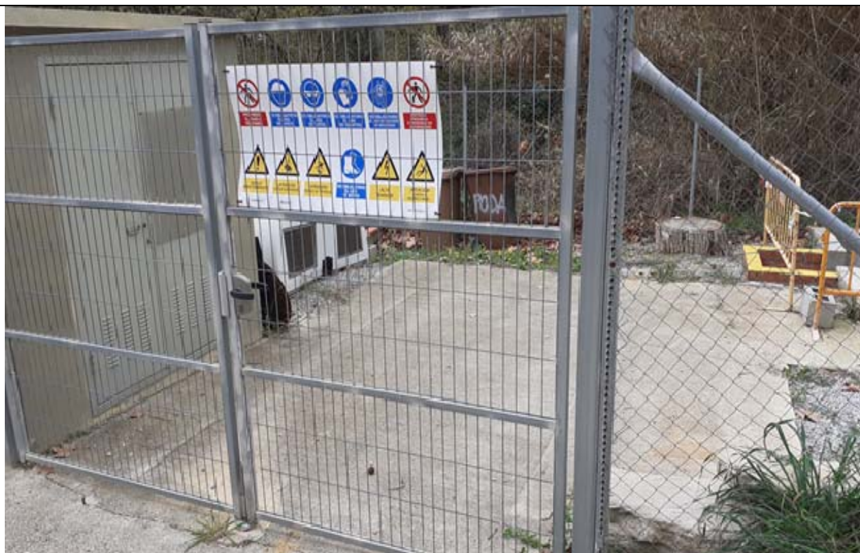
Foto 7. .Entrada a l'EDAR
