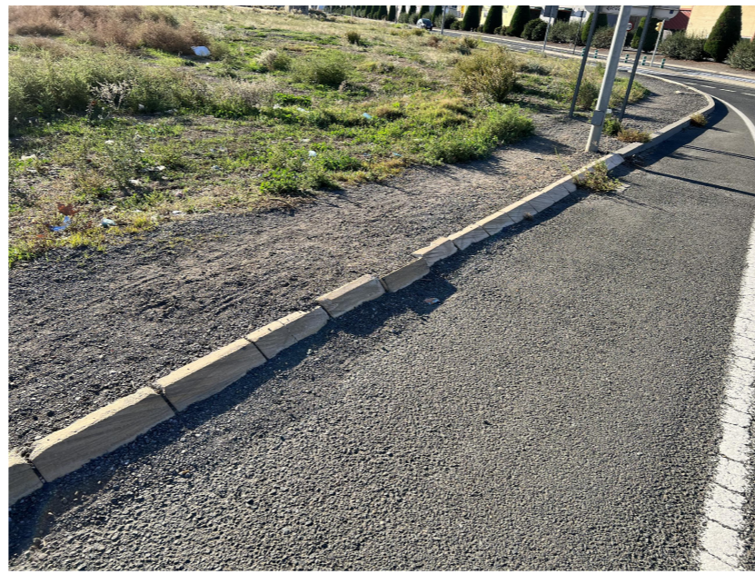
Foto: Tram de vorada a demolir i restituir
