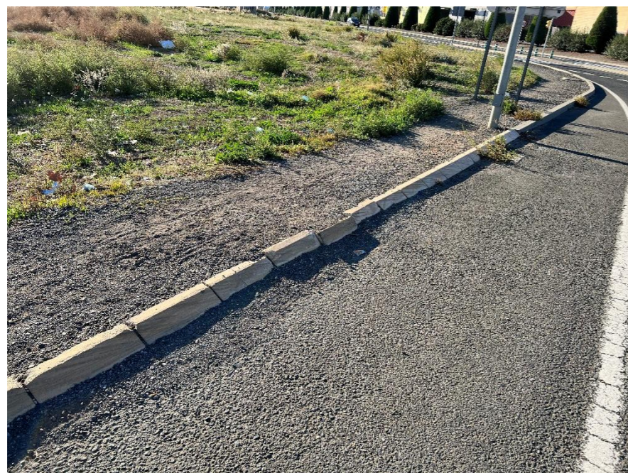
F10. Vorera 3. Restitució vorada afectada
