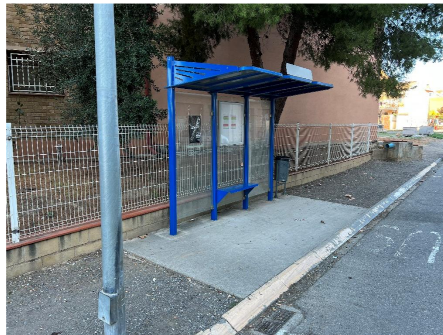
F05. Vorera 2. Parada BUS a mantenir - Demolició paviment.
