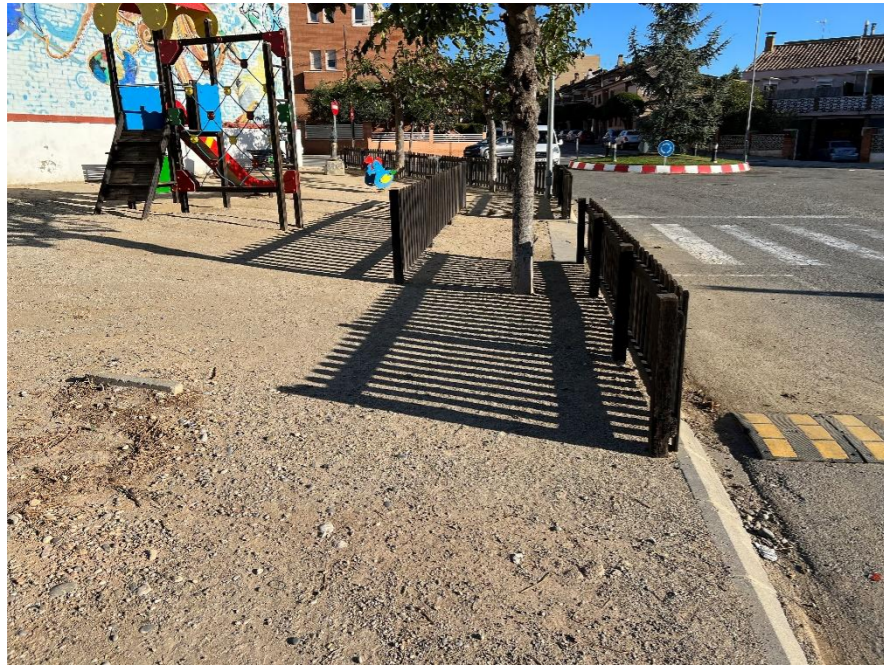
F01. Vorera 1. Inici actuació – desplaçament barana interior
