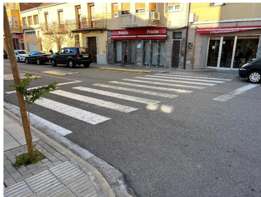
F18. Actuació Gual 8. Demolició gual vianants
