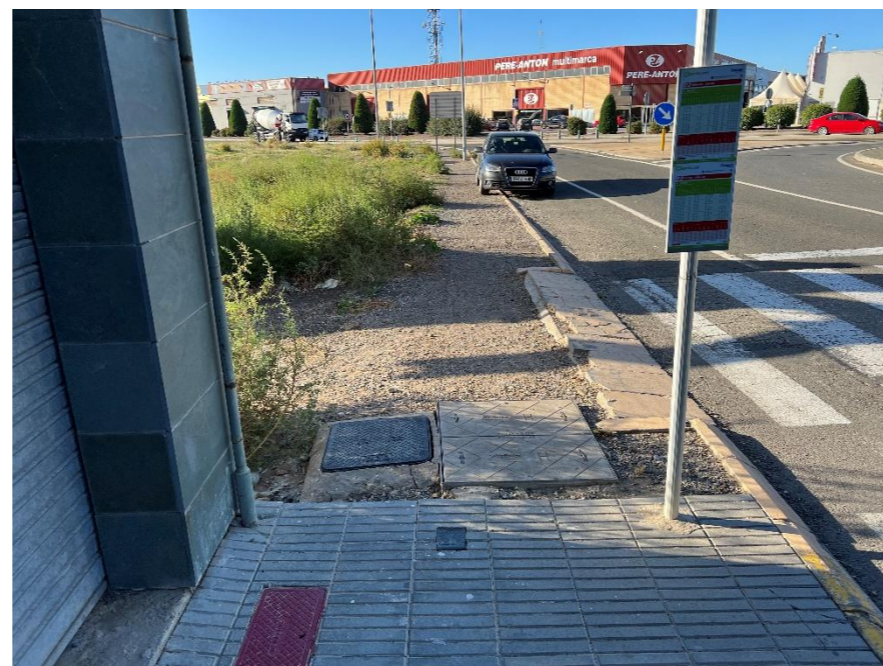
F11. Vorera 3. Final actuació – demolició i restitució gual
