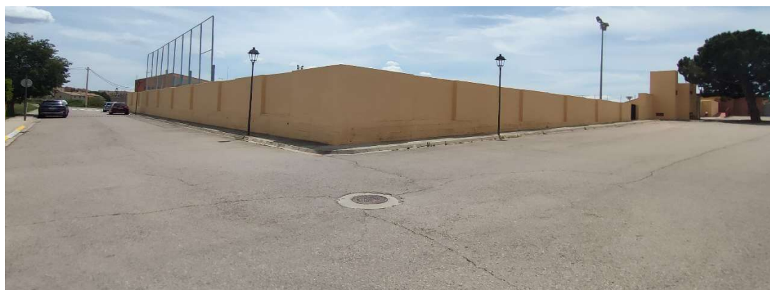
Vista del camp des del carrer de Sant Roc
