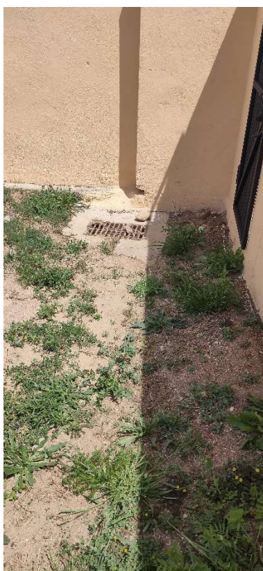
Detall dels canals d'evacuació d'aigües fets directament sobre la plataforma de sauló
