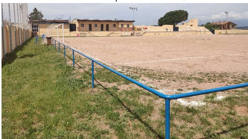
Vista del camp des del córner SE
