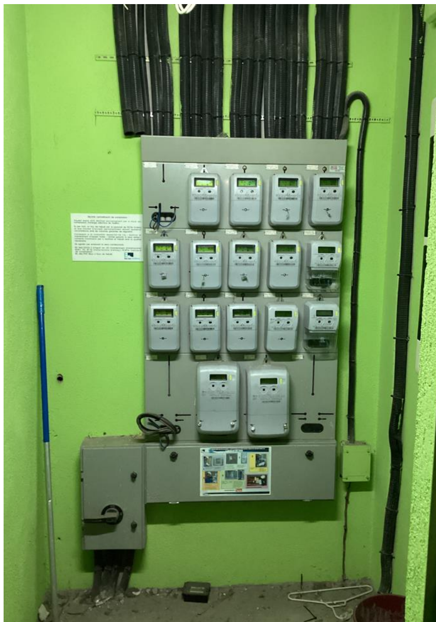
Fig. 4.5. Centralització de comptadors
