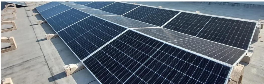
Fig. 7.4. Estructura de subjecció Solarbloc.
