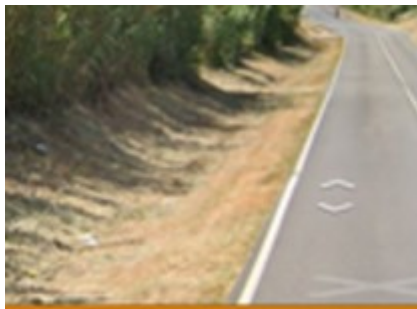
Cuneta no revestida
