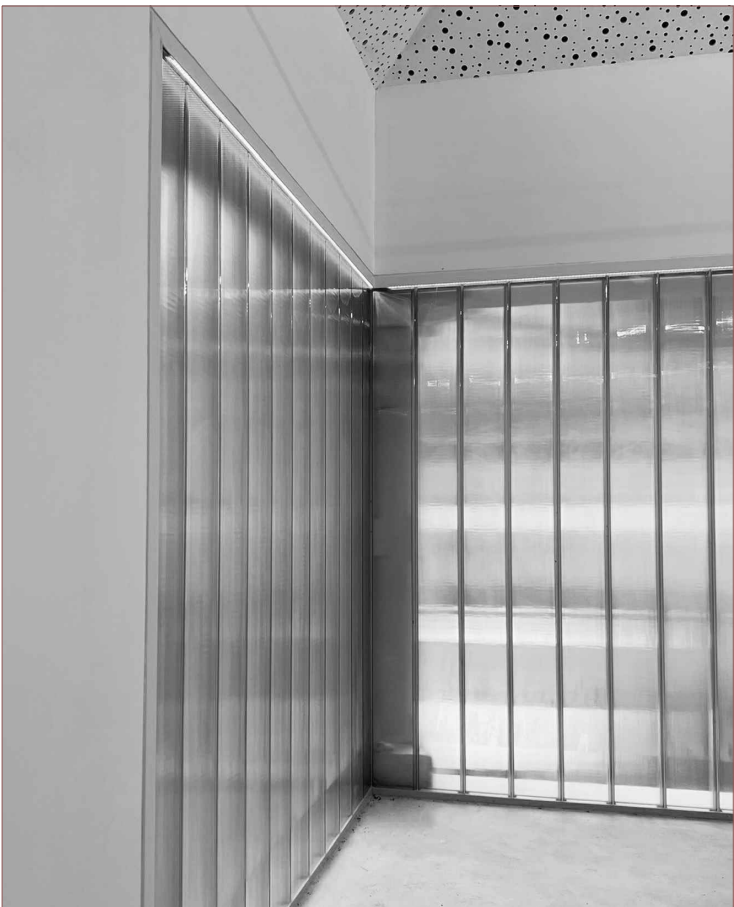
DETALL OBERTURA AMB VISTES A LA PLAÇA DE L'HARO
