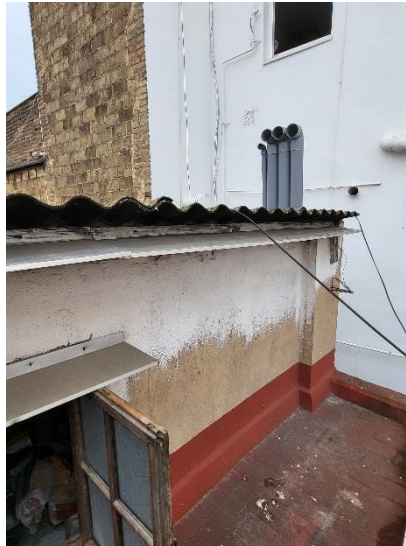
2 Coberta inclinada de fibrociment
