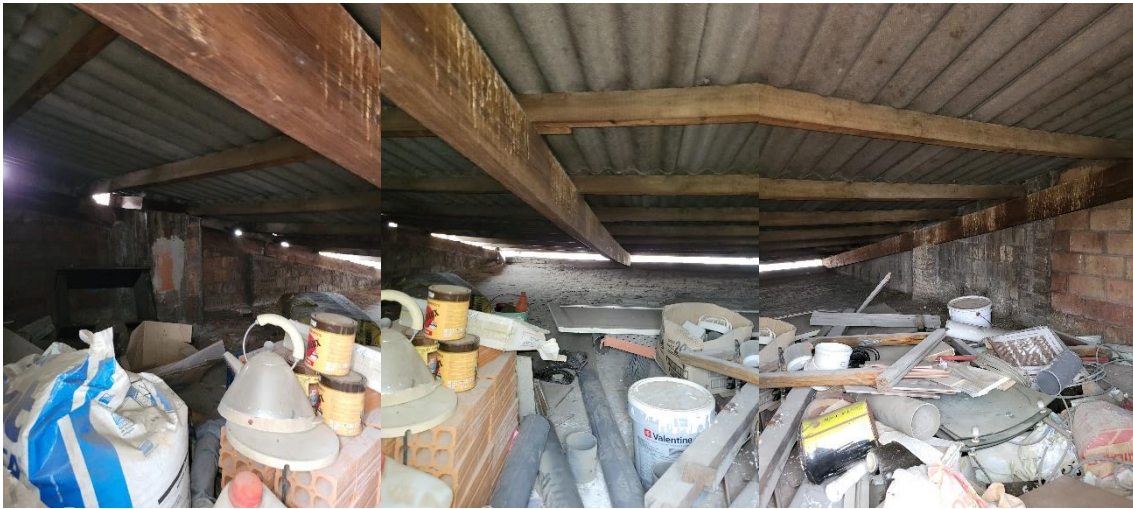
Foto 3. Material d'obra sota coberta inclinada.
