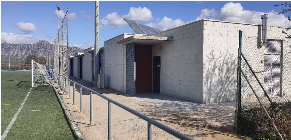
Edifici de vestuaris amb detall de la banda, canaleta, barana i xarxa de protecció
