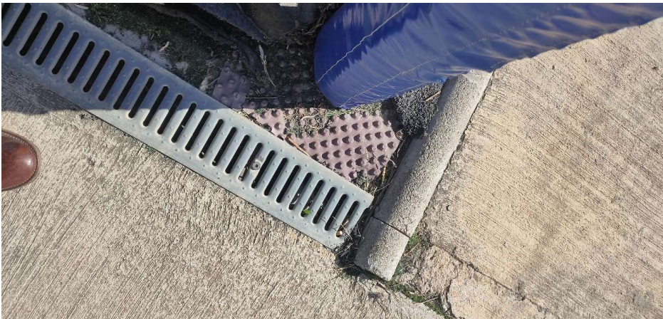
Detall de la canaleta i la vorada de formigó que delimita el camp
