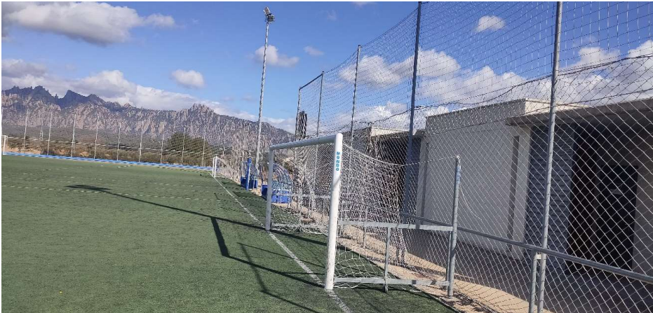
Detall de les porteries de F7 abatibles que es renovaran
