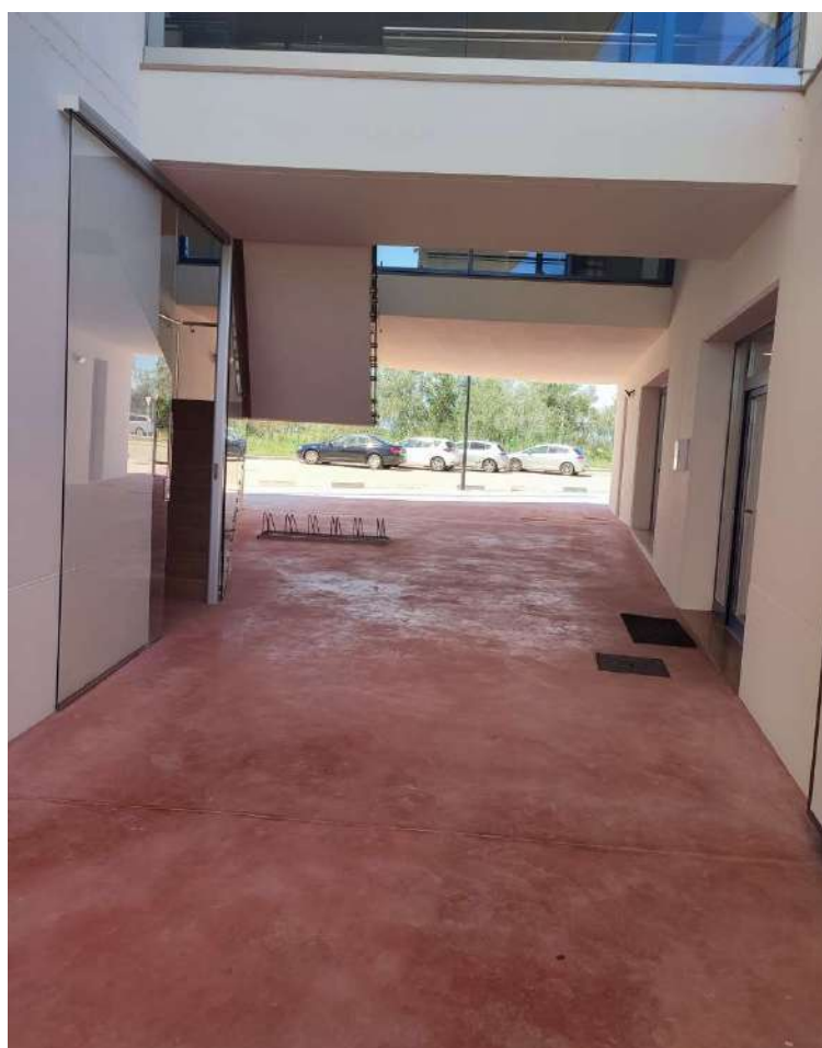
Passadís interior PB edifici entre zona administració confraria i zona de venda
