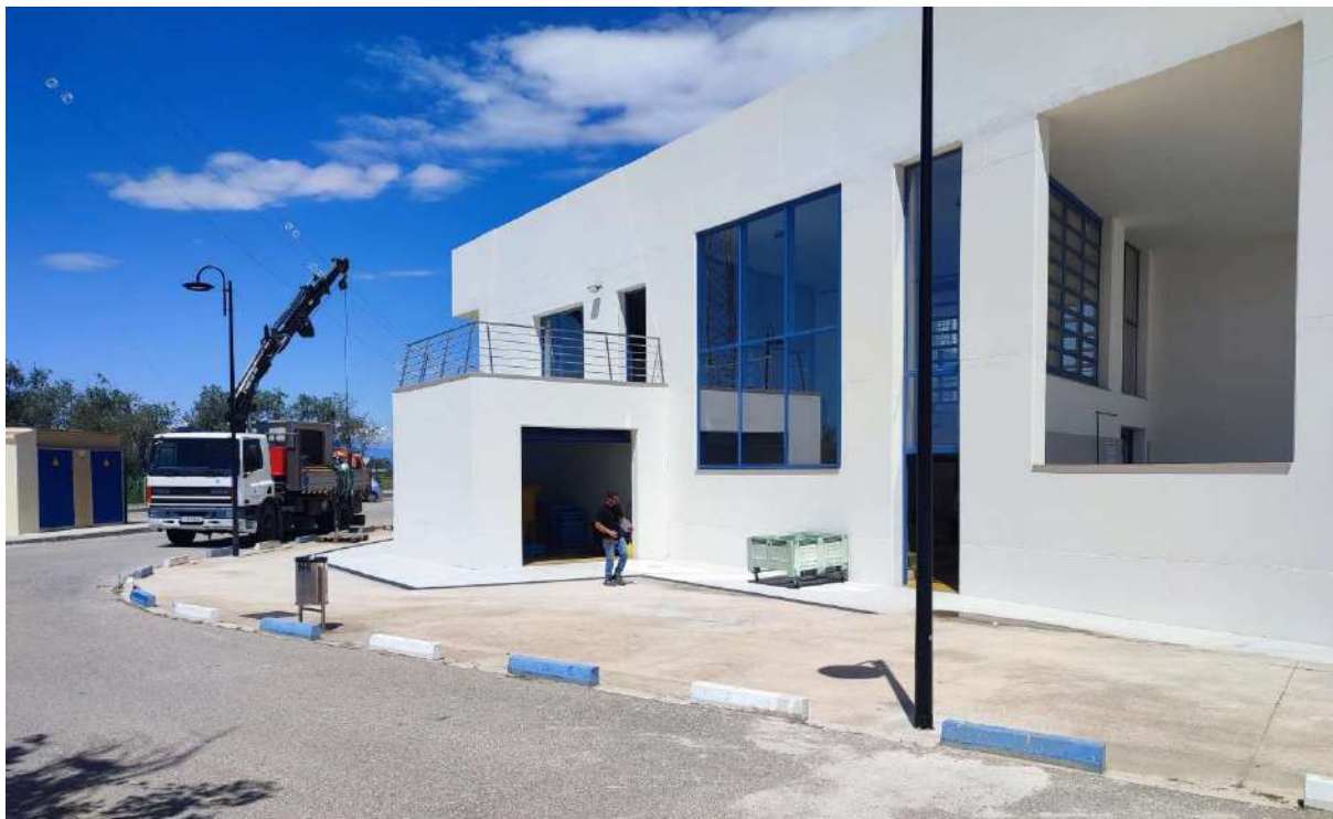
Façana sud edifici. Accés zona recollida caixes netes
