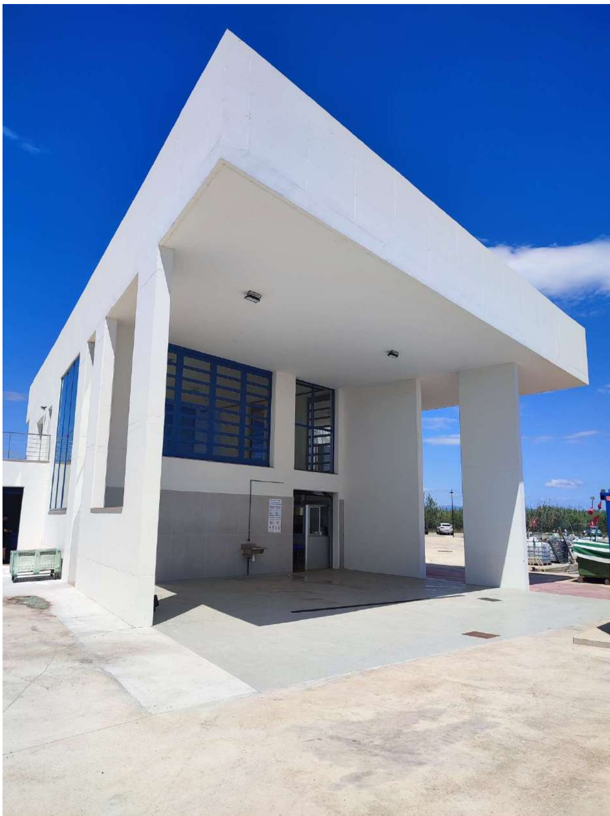
Façana est edifici, accés zona venda
